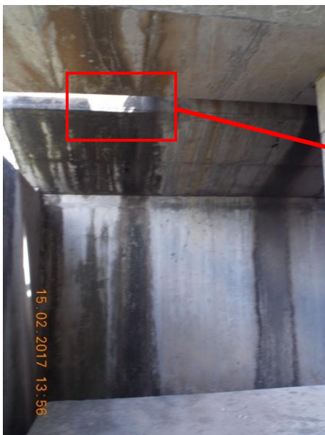
Figura 6. Descarga del ducto de drenaje de las juntas en la zona detrás de la viga cajón y manchas de humedad en la pared del cabezal del bastión 2.
