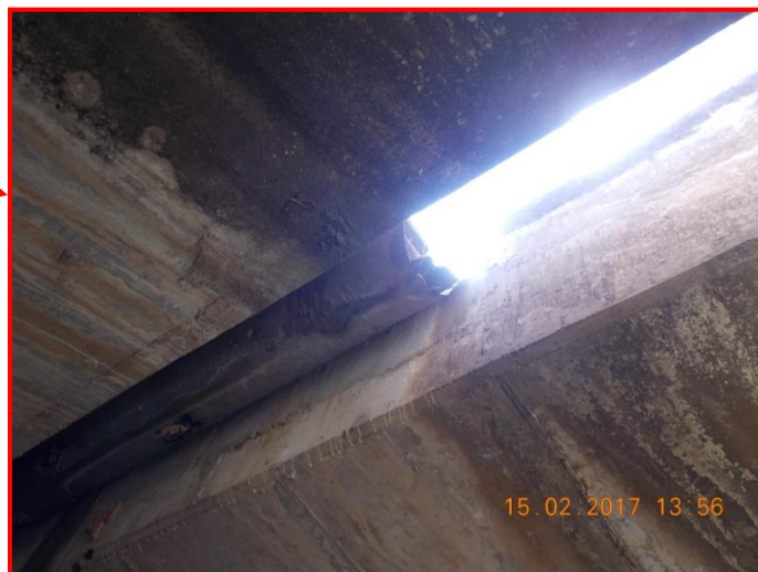
Figura 6. Descarga del ducto de drenaje de las juntas en la zona detrás de la viga cajón y manchas de humedad en la pared del cabezal del bastión 2.
