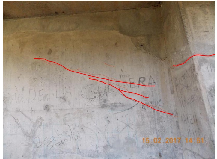
(b) Pared del costado aguas arriba del cajón cerca del bastión 2
