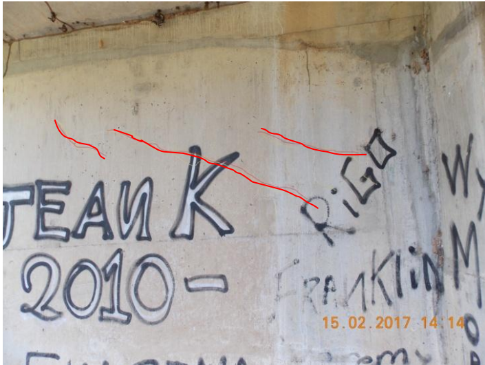
(a) Pared del costado aguas abajo del cajón cerca del bastión 1
