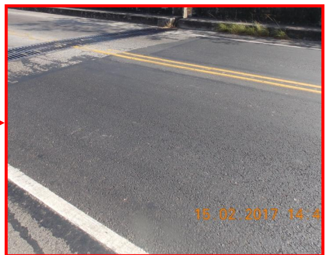
Figura 9. Pulimiento y desprendimientos de agregados de la carpeta asfáltica de ambos accesos.
