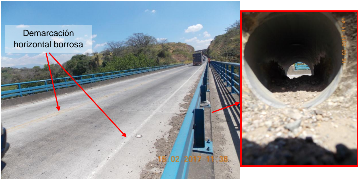
Figura 3. Demarcación horizontal borrosa y acumulación de sedimentos en bordillos y ductos de drenaje que descargan en el paso peatonal.
