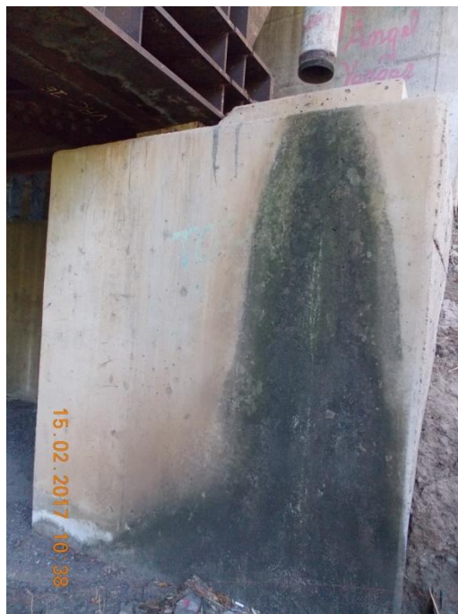
Figura 4. Ducto de drenaje que descarga directamente sobre el bastión 2.
