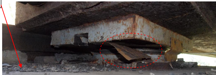
(b) Apoyo lado aguas arriba sobre bastión 2.
