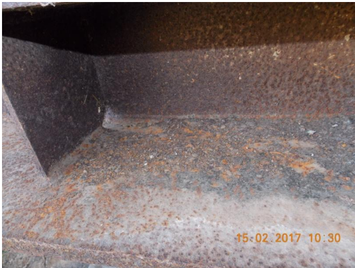
Figura 16. Corrosión con pérdida de sección leve en extremo de viga principal.
