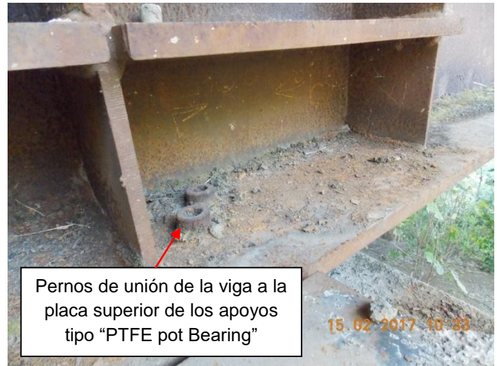
Figura 16. Corrosión con pérdida de sección leve en extremo de viga principal.
