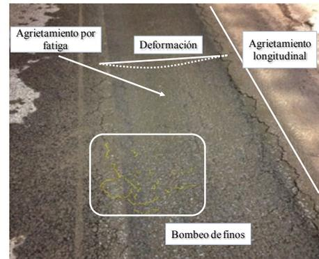
**Figura 4. Deterioros en la sección AC2-Húmeda al momento de la falla.**
