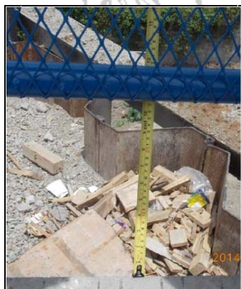
Figura 6. Medición de distancia libre inferior de baranda peatonal, caso del puente 2. y Figura 7. Espacio libre de baranda peatonal suficiente para el paso de persona adulta.
