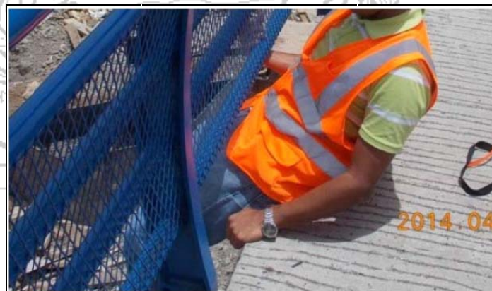
Figura 6. Medición de distancia libre inferior de baranda peatonal, caso del puente 2. y Figura 7. Espacio libre de baranda peatonal suficiente para el paso de persona adulta.
