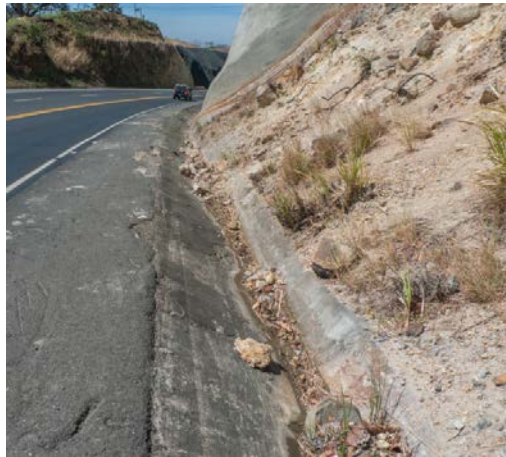
Figura 48 Talud del estacionamiento 38+600
