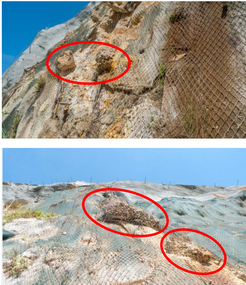
Figura 52 Acumulación de bloques de roca y de concreto en la malla metálica
