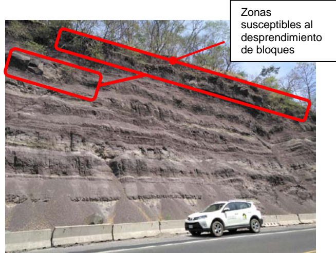
Figura 57 Vista del talud al lado derecho del estacionamiento 73+000.
