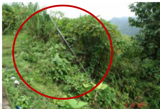
Fotografía 7. Barrera sustituida sin retirar del sitio.
