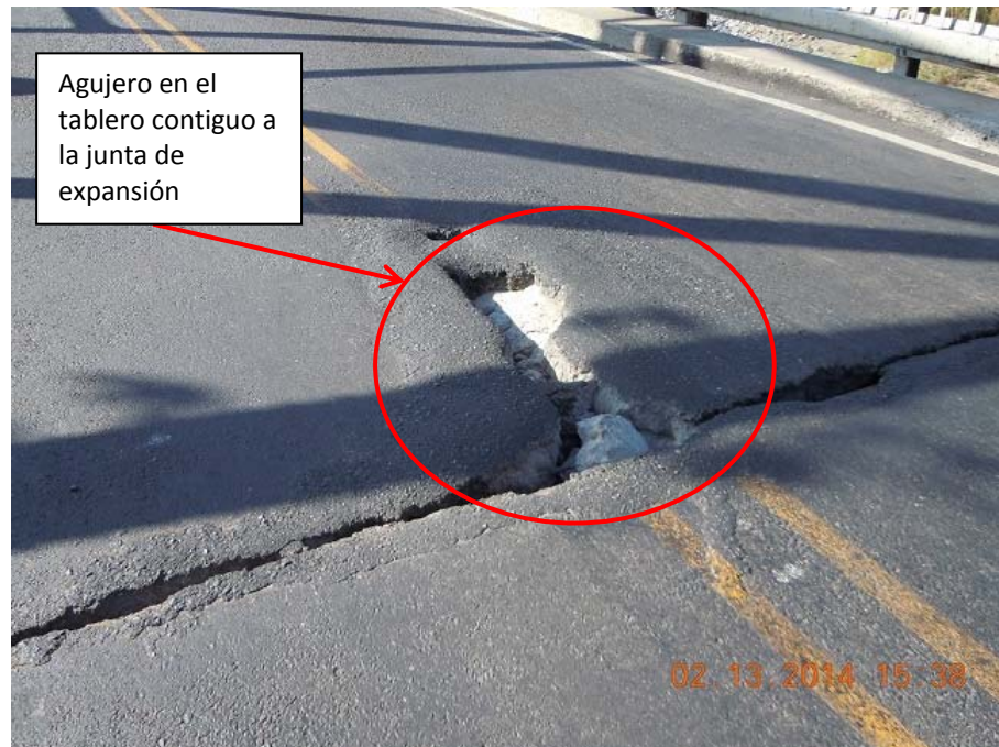
Figura 9. Estado de la junta el día 13 de febrero del año 2014.
