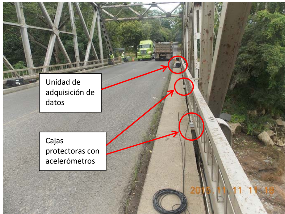
Figura 23. Vista de superestructura con equipos en las aceras. Nótese que el monitoreo no interrumpe el tránsito de vehículos.
