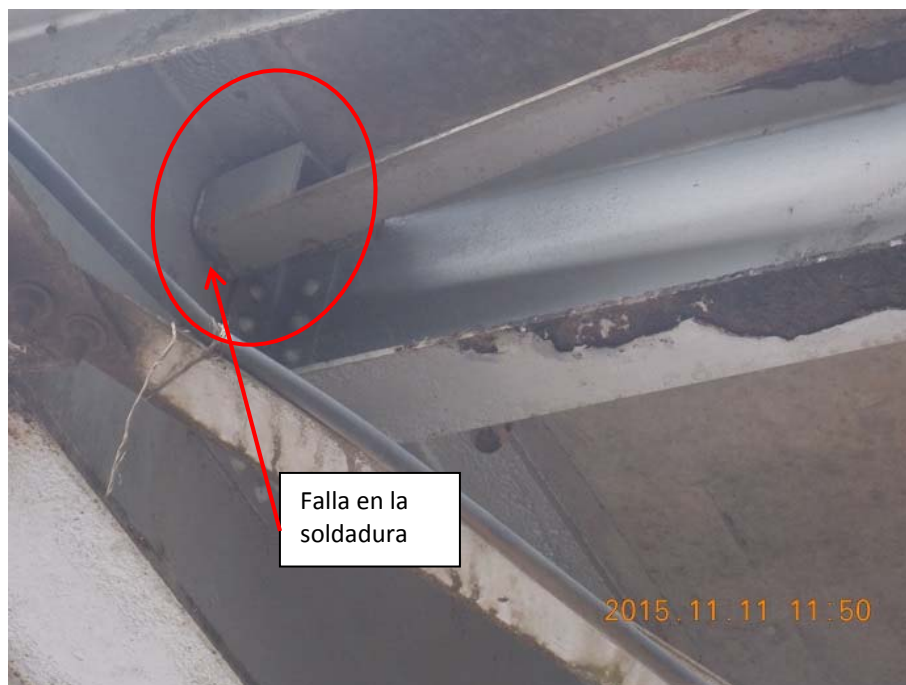
Figura 15. Falla de la soldadura de un elemento de refuerzo indicado en los planos de 1997. Fotografía del día 11 de noviembre del año 2015.
