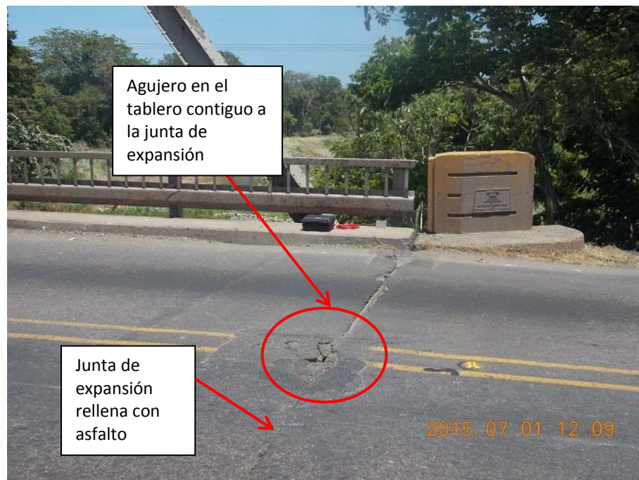
Figura 12. Estado de la junta el día primero de julio del año 2015.
