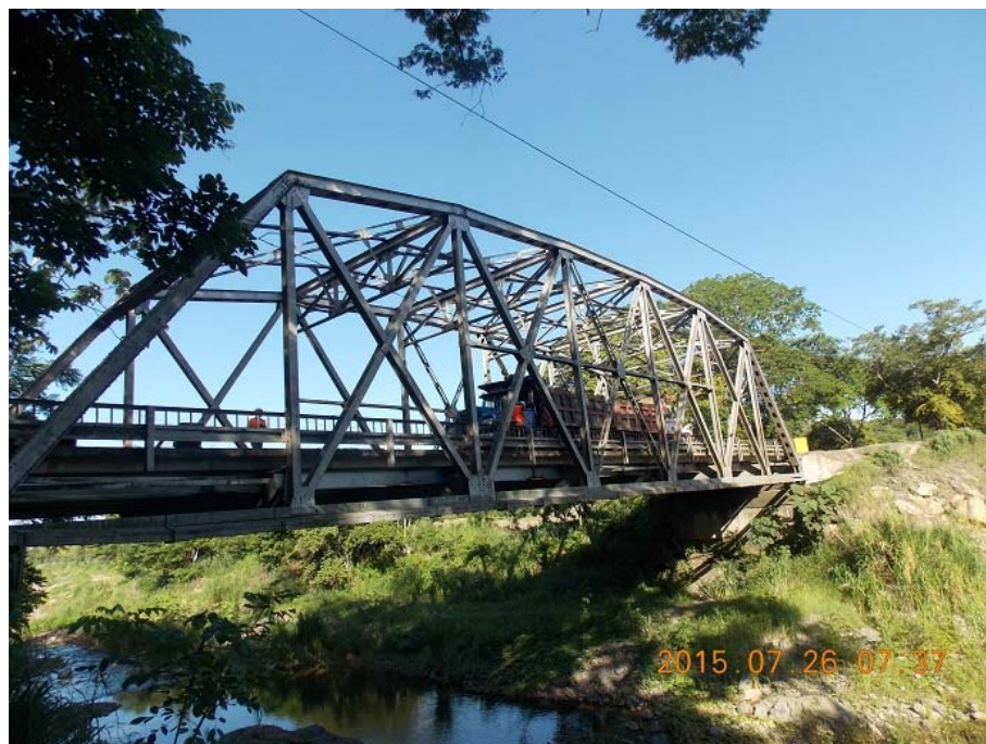
Figura 4. Vista lateral del costado sur.
