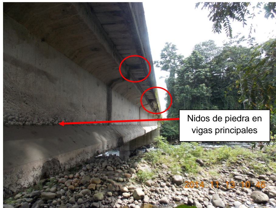
Figura 3. Evidencia de descarga directa de agua sobre las vigas debido a ausencia de tubos de extensión. Nidos de piedra en vigas principales.
