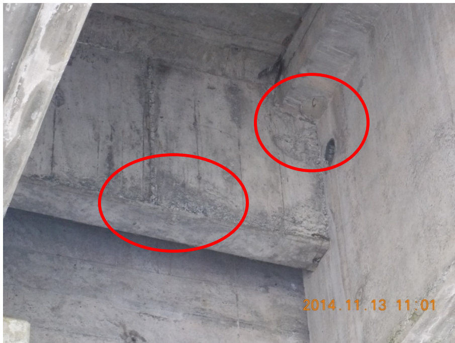
Figura 10. Nidos de piedra en vigas diafragma de la superestructura 2..
