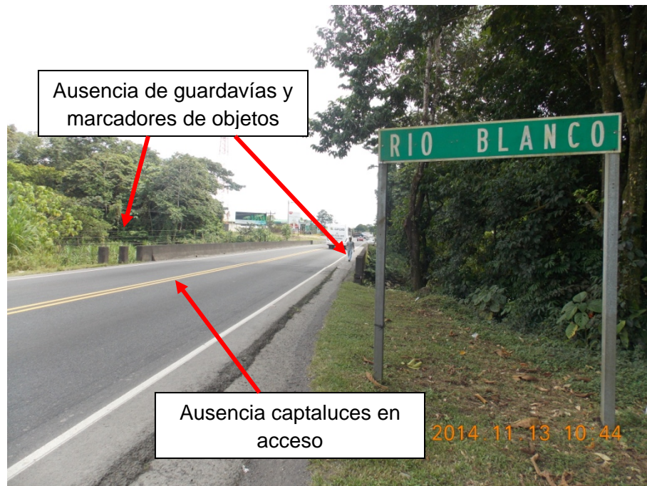
Figura 1. Rótulo colocado únicamente en acceso 2, ausencia de guardavías y marcadores de objetos, ausencia de captaluces en accesos.
