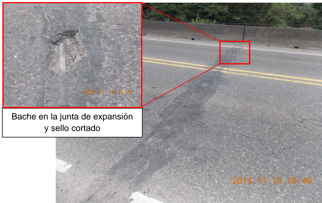
Figura 4. Junta de expansión obstruida con asfalto sobre la pila.
