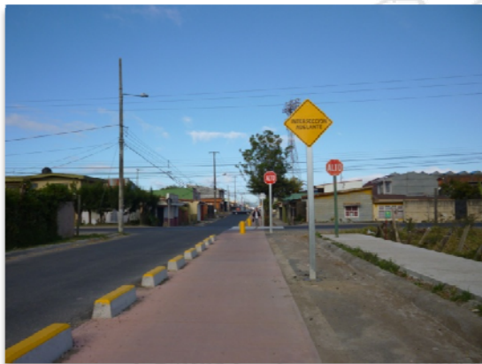
Figura 1: Duplicidad de señales de ALTO Nota: Fotografía tomada el 9 de febrero 2013.
