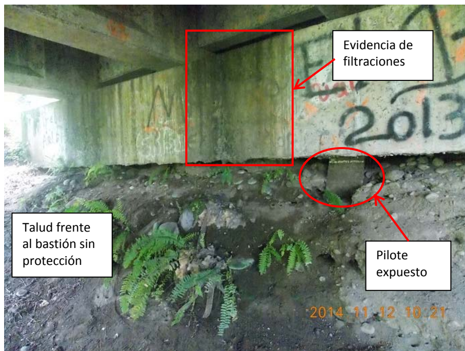
Figura 16: Vista del bastión 2.
