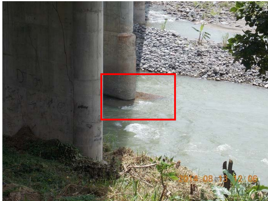
Figura 20: Exposición de la placa de cimentación de la pila 2.
