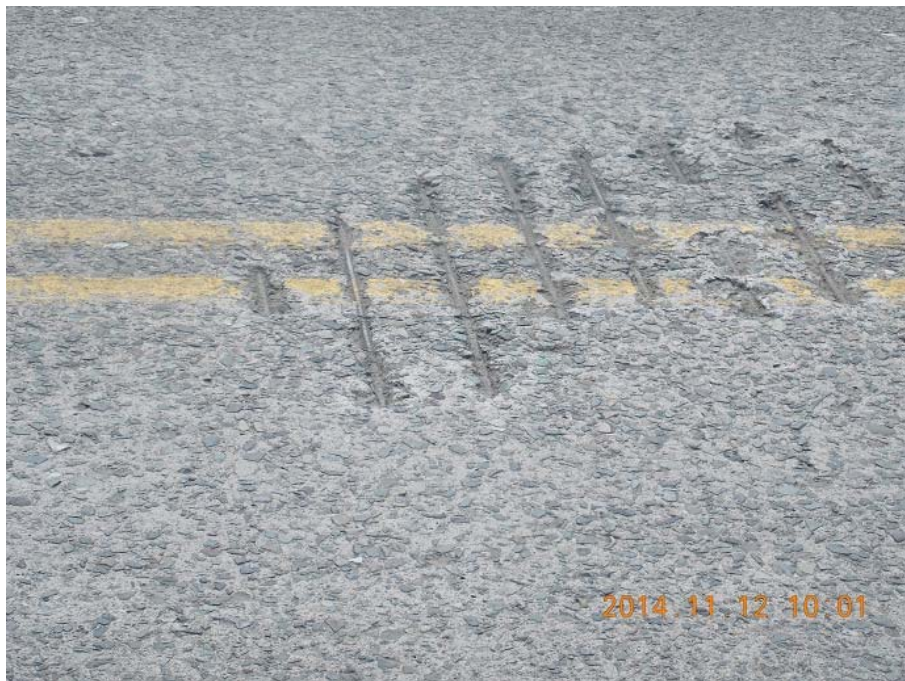
Figura 11: Exposición del refuerzo principal en la losa del tablero.
