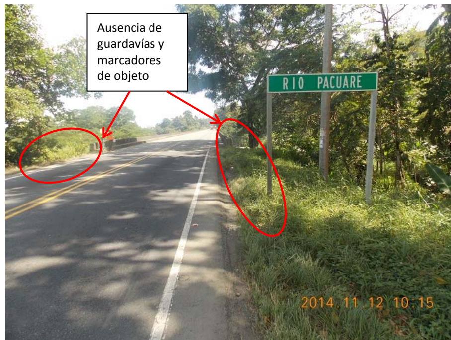
Figura 2: Ausencia de guardavías y marcadores de objeto en acceso 2
