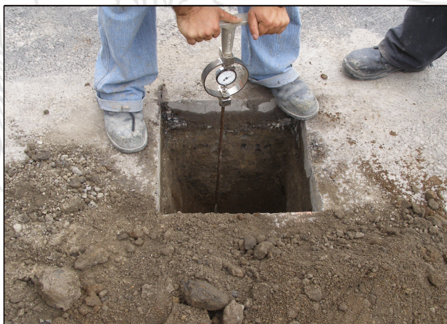
Figura 26. Prueba de CBR en sitio.
