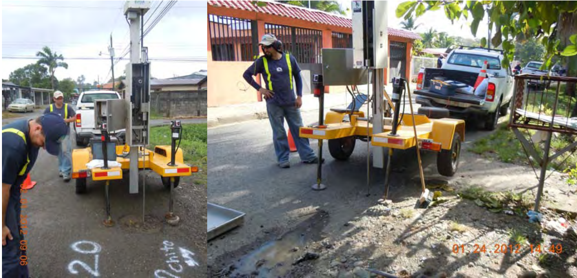
Figura 11. Medición a cielo abierto con el Cono de penetración dinámico.
