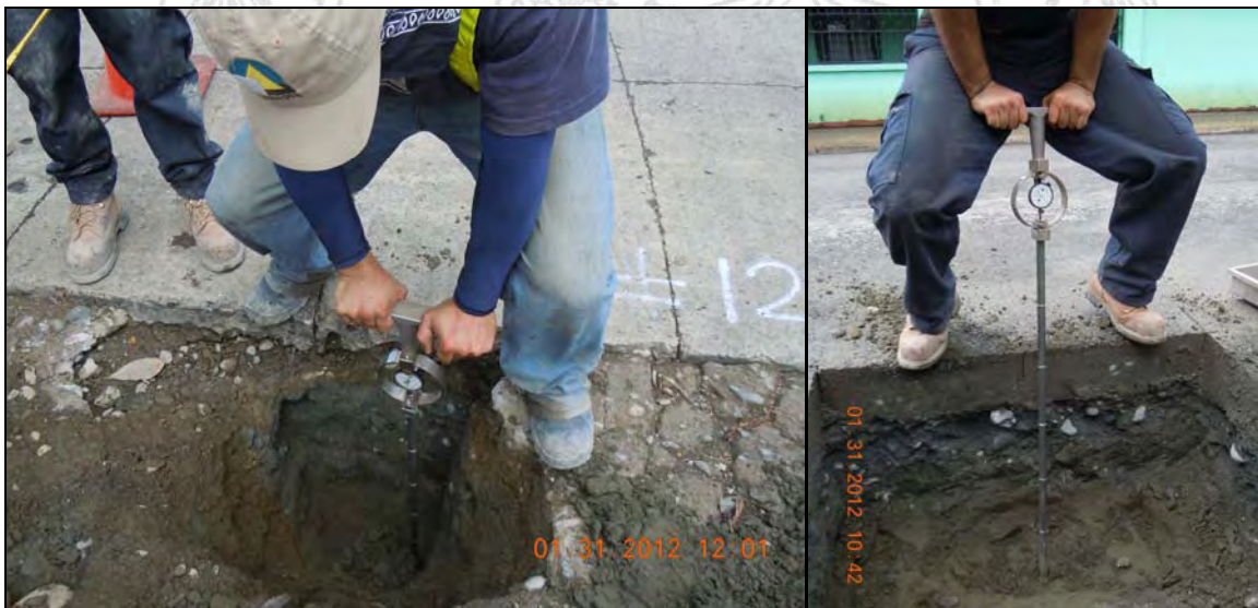
Figura 12. Medición de CBR en sitio con el anillo de carga manual.
