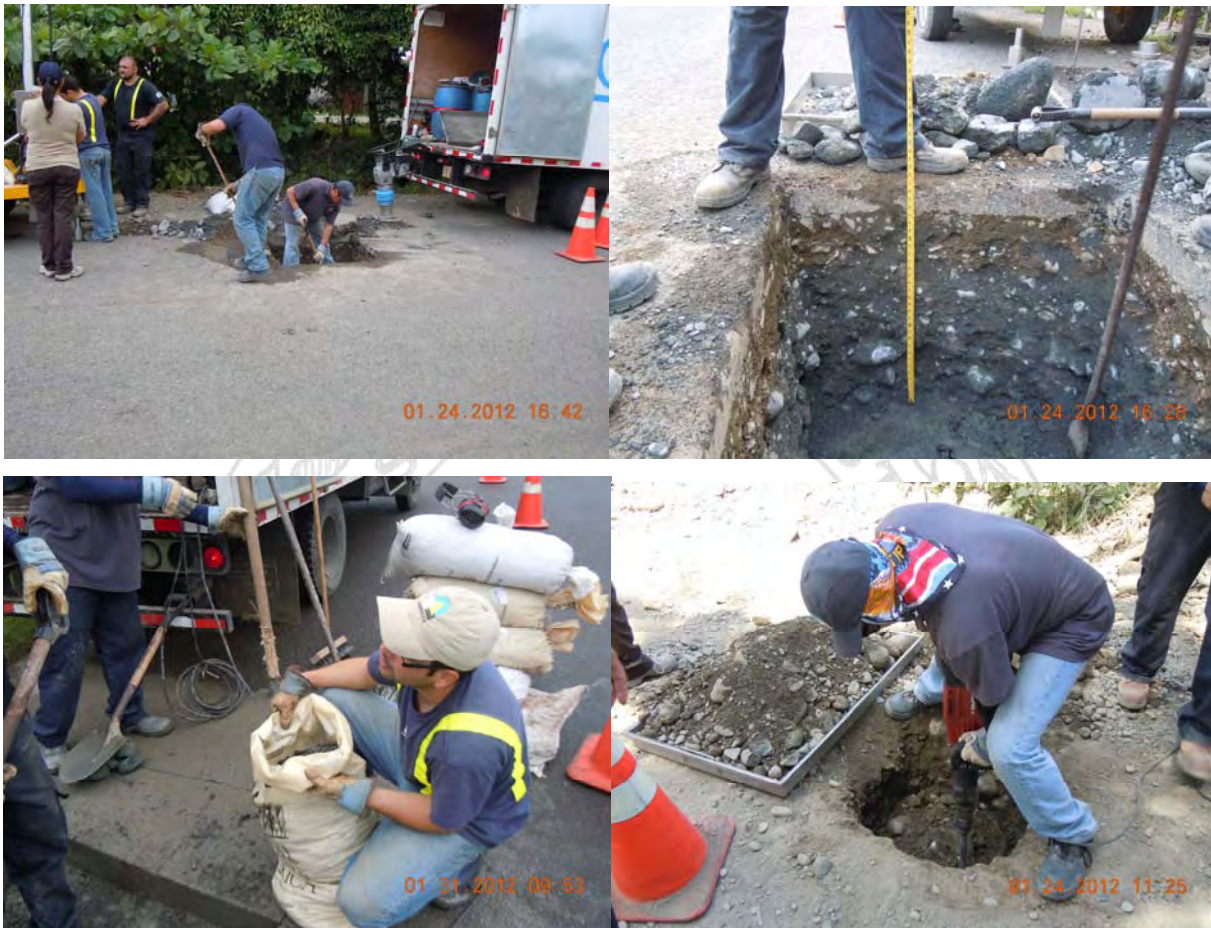
Figura 9. Sondeos a cielo abierto.
