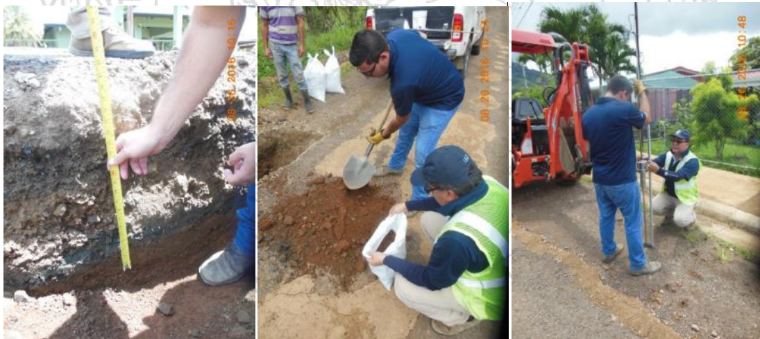
Figura 7. Excavación de sondeos a cielo abierto, muestreo y ensayos DCP.
