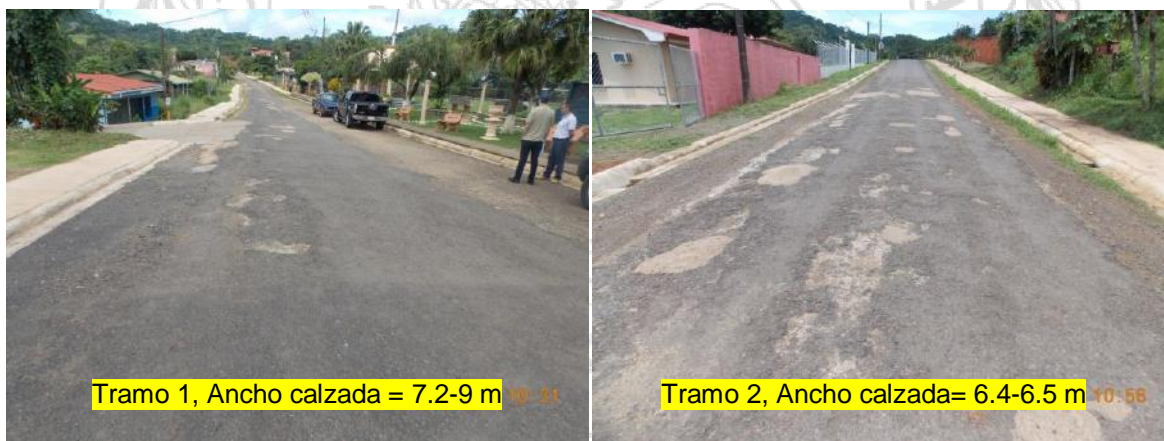
Figura 3. Anchos de calzada observados en tramos del camino analizado.
