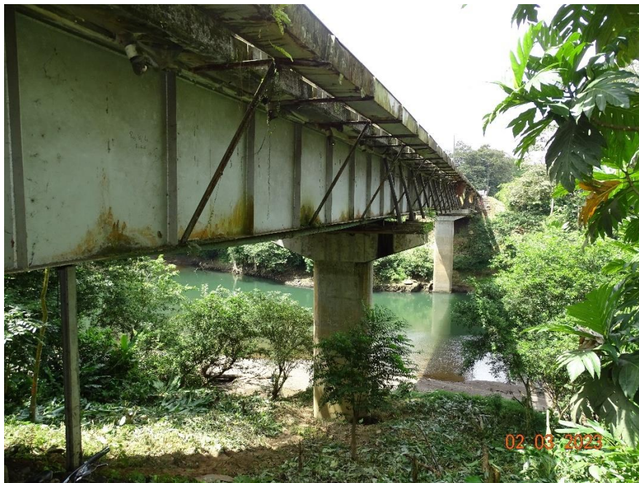
Figura 4.3. Vista lateral del costado aguas arriba del puente
