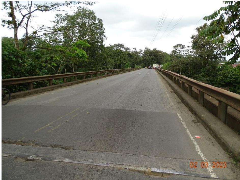
Figura 4.2. Vista a lo largo de la línea de centro del puente hacia Puerto Viejo
