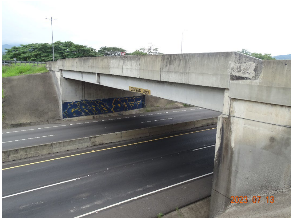
Figura 4.3. Vista lateral del costado norte del puente
