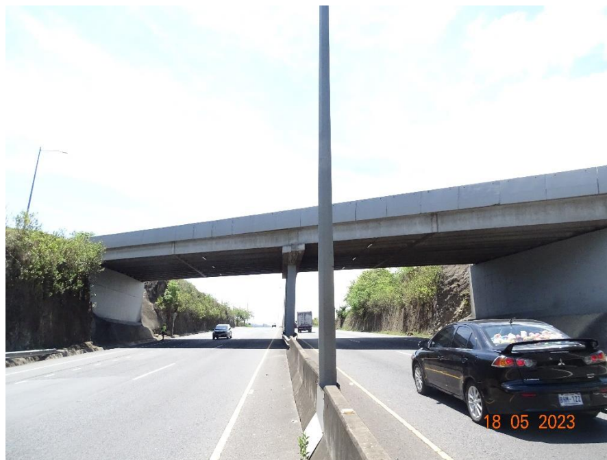
Figura 4.3. Vista lateral del costado oeste del puente
