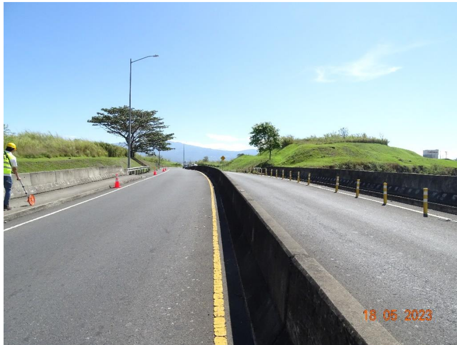
Figura 4.2. Vista a lo largo de la línea de centro del puente hacia carril de ingreso a Ruta Nacional n.º 27
