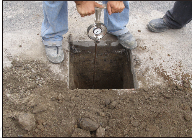
Figura 22. Prueba de CBR en sitio.
