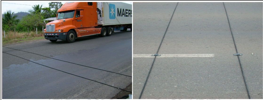
Figura 4. Cables y contadores automáticos en sitio.
