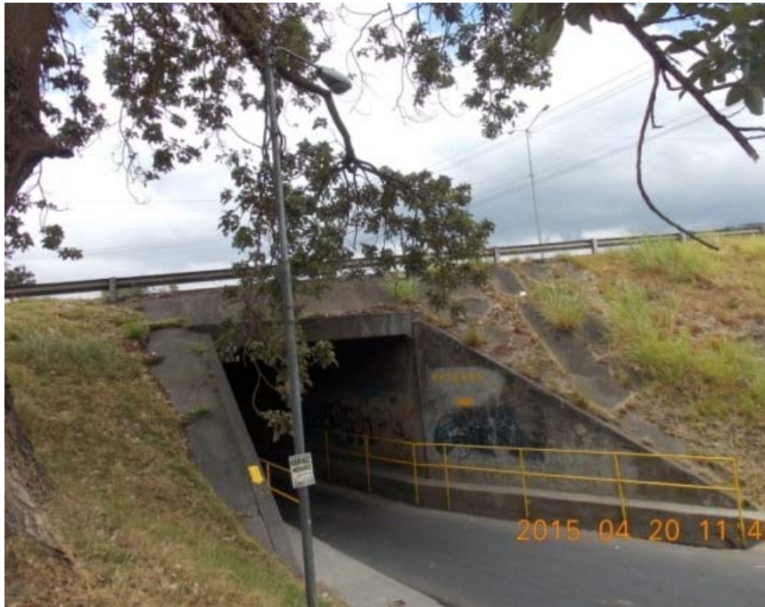
Figura 5.53. Vista del acceso inferior sur.
