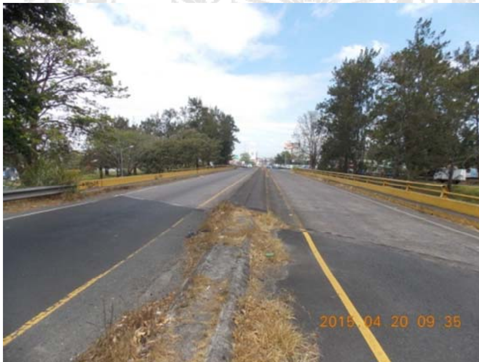
Figura 5.3. Vista a lo largo de la línea centro desde el lado norte.
