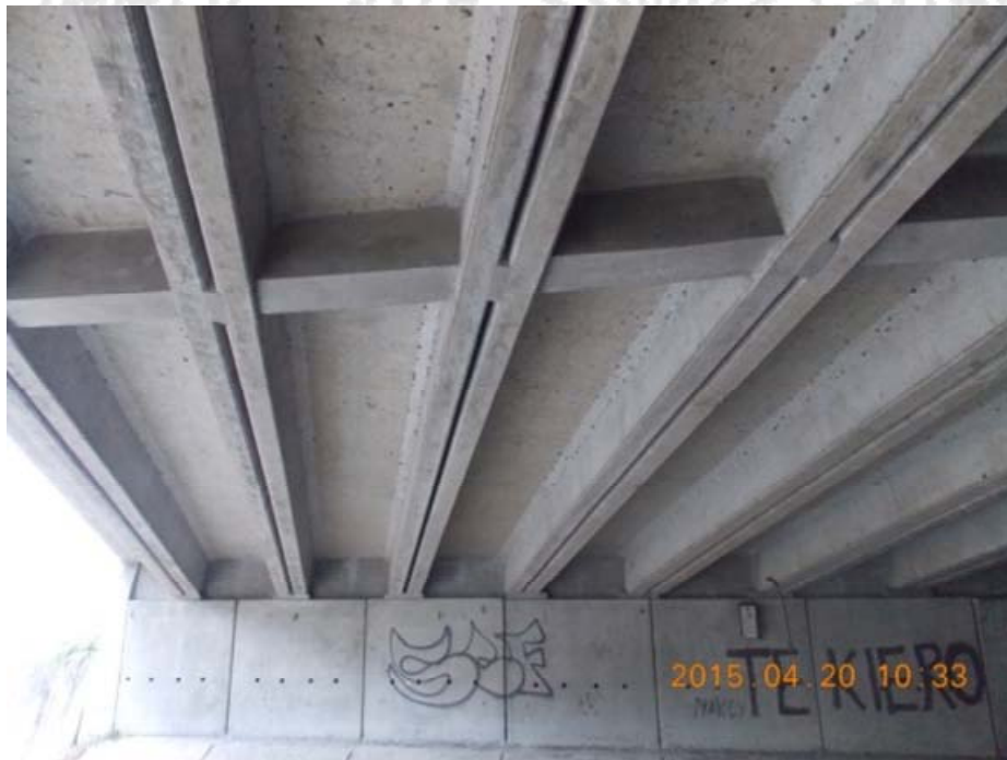
Figura 5.29. Vista inferior desde el lado este.
