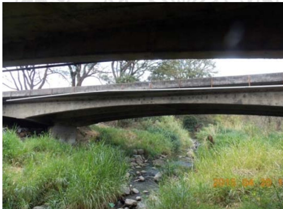
Figura 5.36. Vista lateral sur del puente ubicado aguas arriba.
