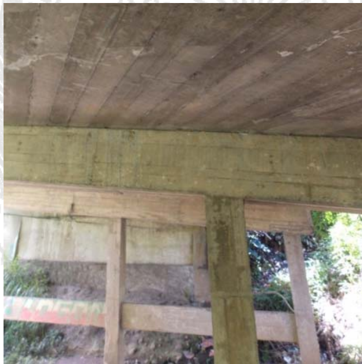
Figura 5.72. Vista inferior desde el acceso oeste.
