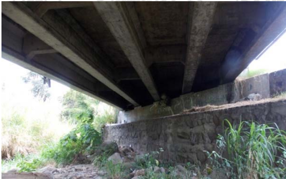
Figura 5.47. Vista inferior desde el lado oeste del puente ubicado aguas arriba.
