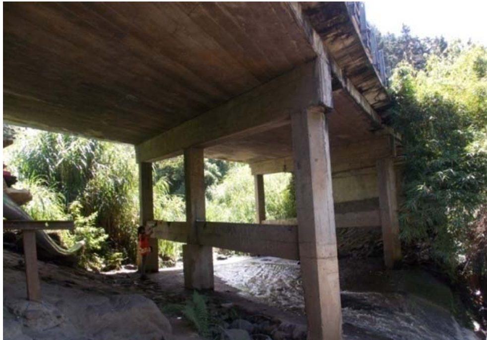
Figura 5.71. Vista lateral general desde el acceso oeste.
