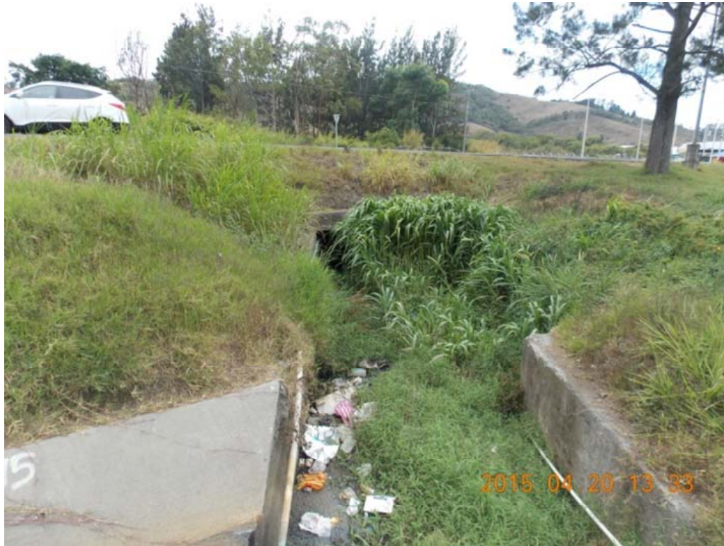
Figura 5.79. Vista del lado norte de la alcantarilla (Google earth®).
