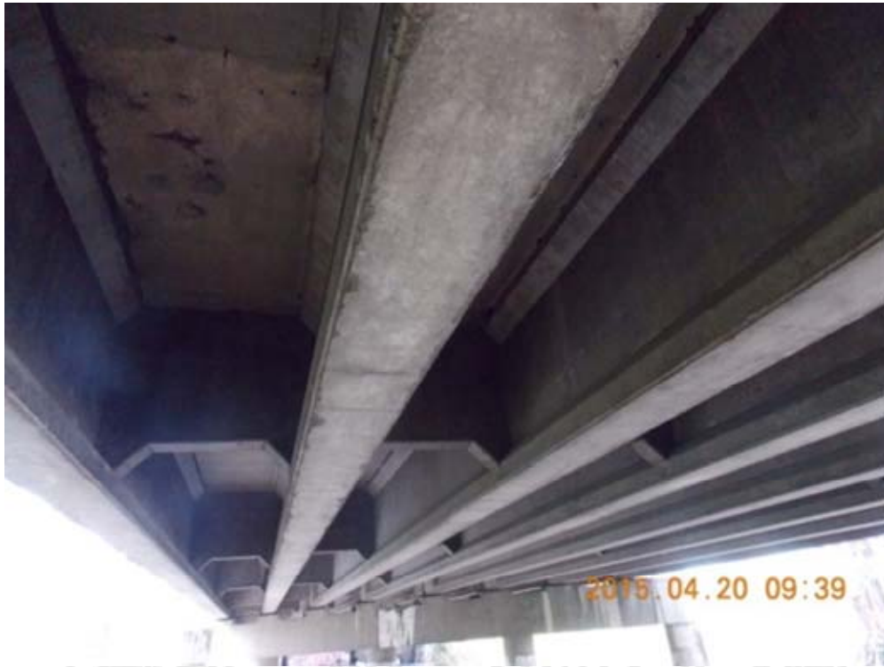
Figura 5.4. Vista inferior desde el lado norte.
