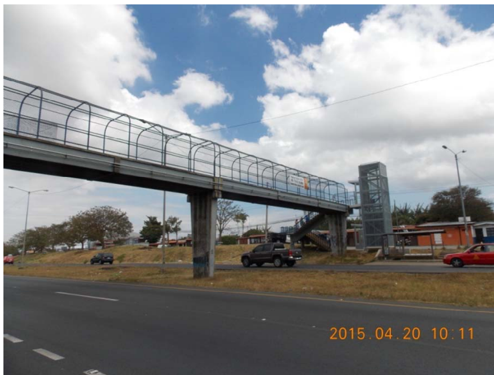
Figura 5.14. Vista lateral este del puente peatonal.
