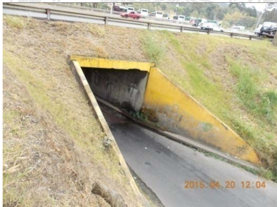
Figura 5.59. Vista del acceso inferior sur.
