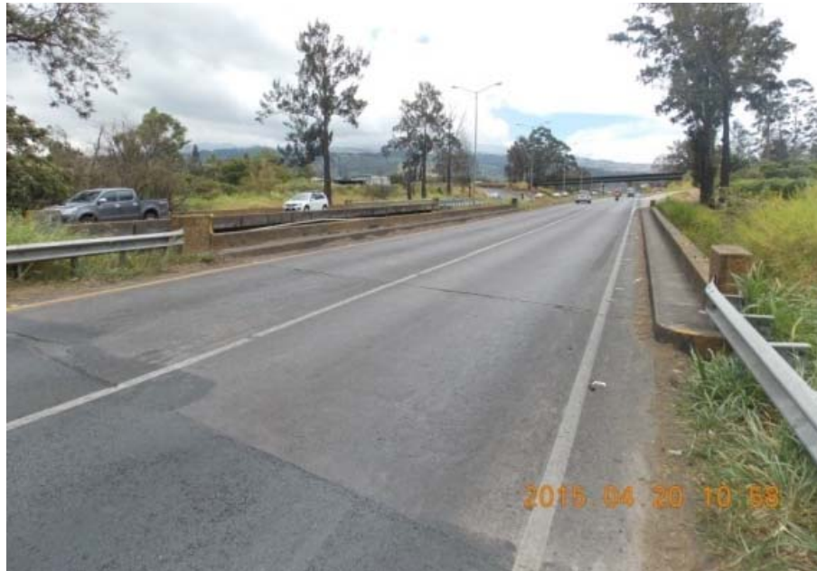
Figura 5.35. Vista a línea centro desde el extremo oeste del puente ubicado aguas abajo.
