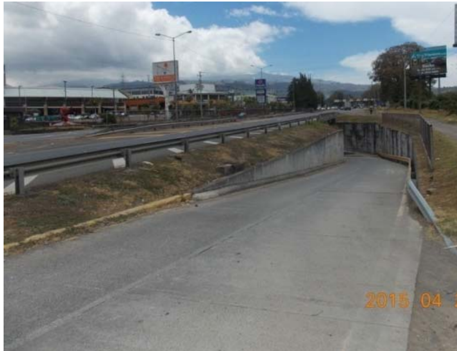
Figura 5.28. Vista del acceso inferior sur del paso a desnivel.
