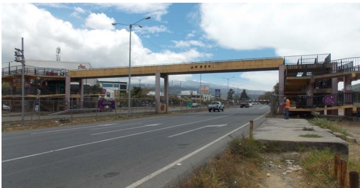
Figura 5.25. Vista del lado oeste del puente peatonal.
