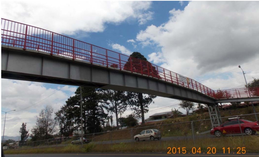
Figura 5.43. Vista lateral del lado este del puente peatonal
