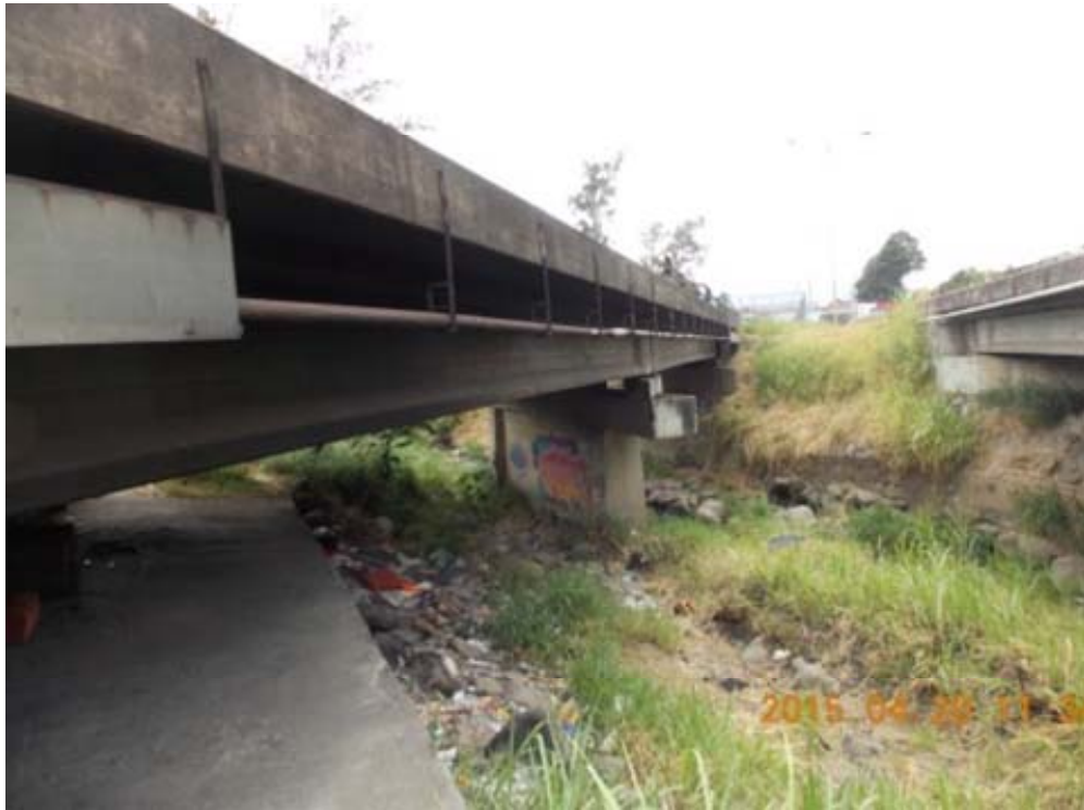
Figura 5.46. Vista lateral sur del puente ubicado aguas arriba.
