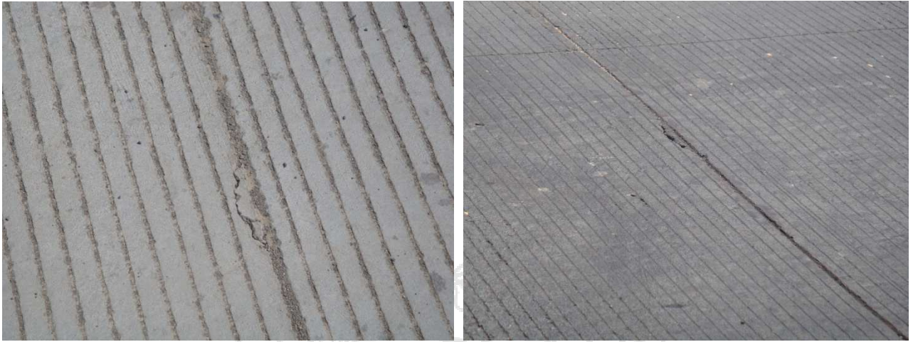
Figura 4. Juntas Fracturadas
