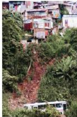
Derrumbe camino a Tibás, después del puente del Virllia. Jorge Castillo
