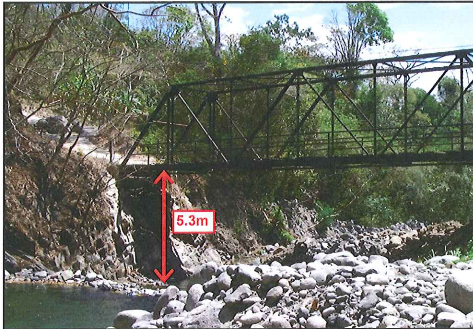
Figura 3. Altura del "Puente Negro"
