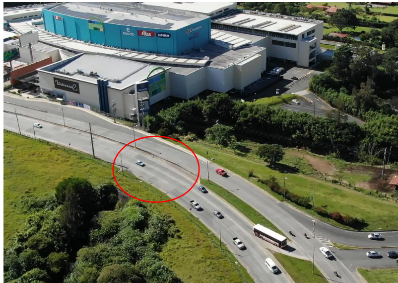
Figura 3. Ubicación alcantarilla Paseo Metrópoli
