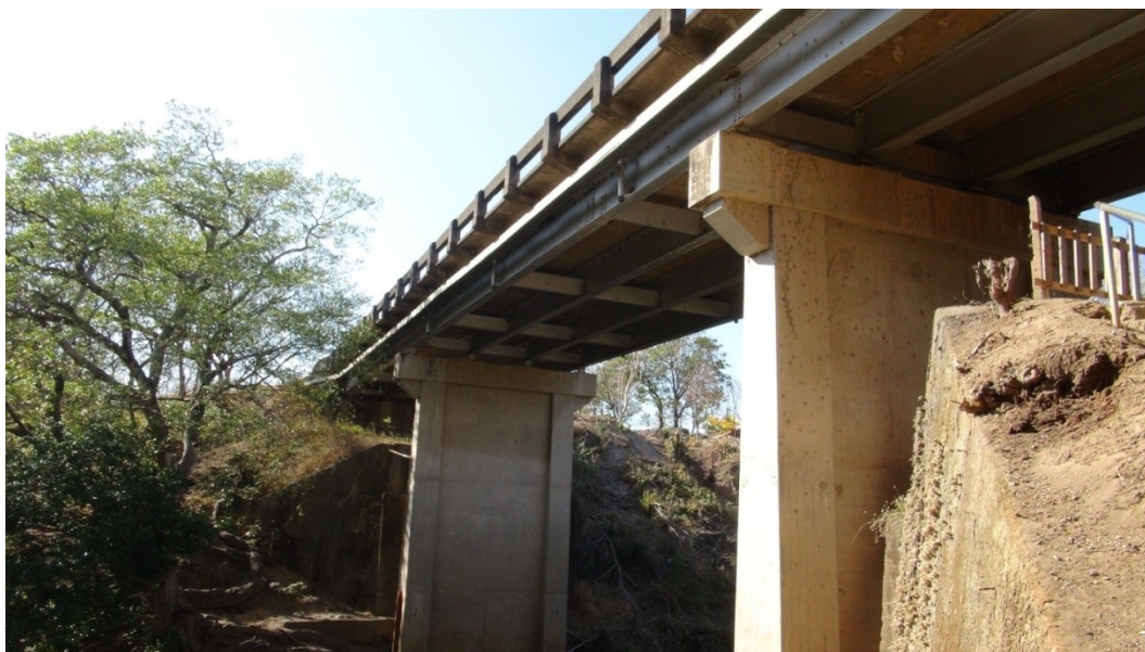
Figura 3: Vista lateral del puente Río Tenorio.
