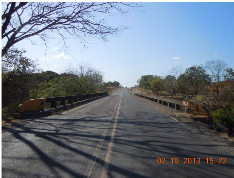
Figura 2: Vista a lo largo de la línea de centro del puente Río Tenorio.
