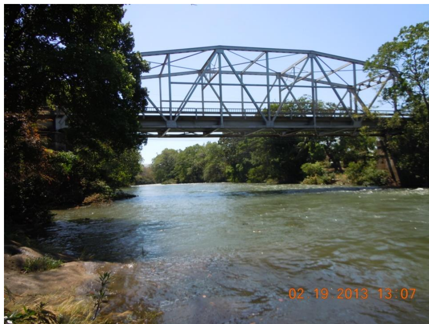
Figura 3: Vista lateral puente sobre el Río Corobicí
