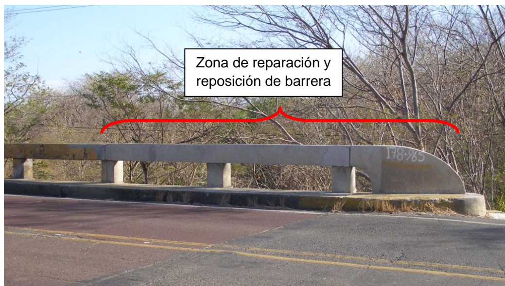
Figura 6. Reparación de la barrera sur del tramo No 3.
