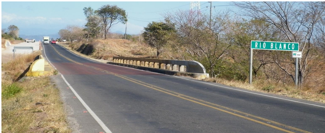
Figura 2: Vista a lo largo de la línea de centro del puente sobre el Río Blanco.
