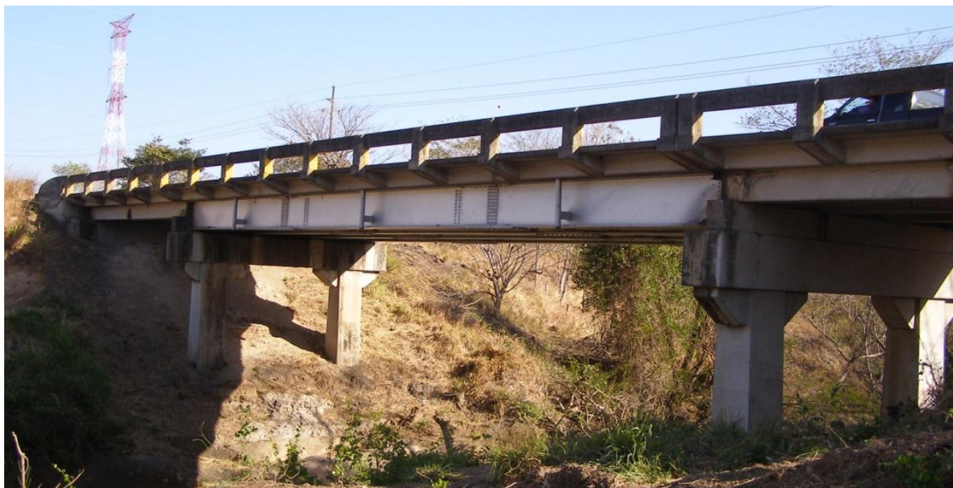
Figura 3: Vista lateral del puente sobre el Río Blanco.
