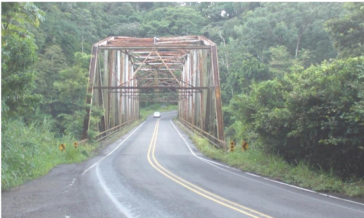
Figura 2: Vista a lo largo de la línea de centro
