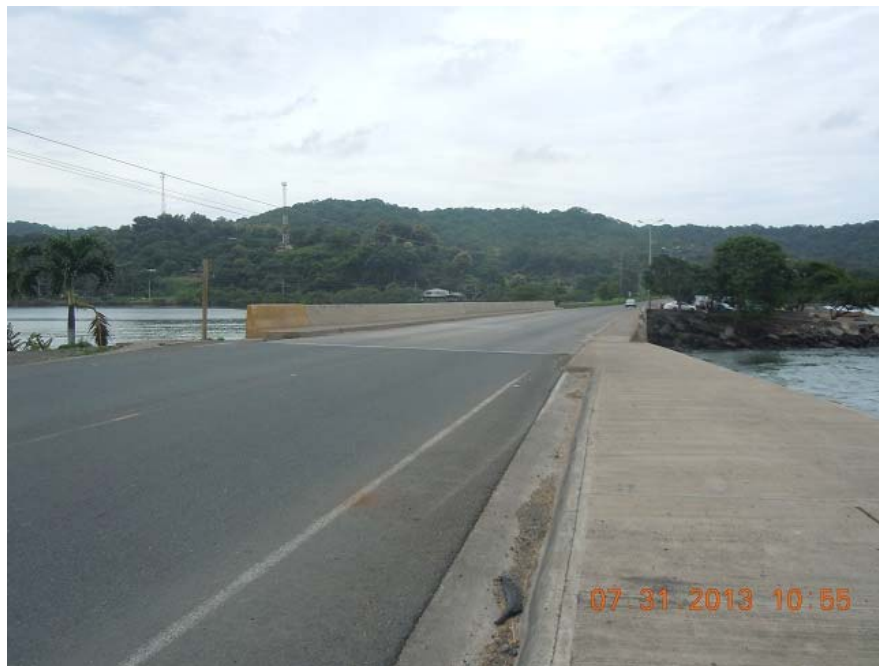
Figura B: Vista longitudinal (desde el extremo Norte).
