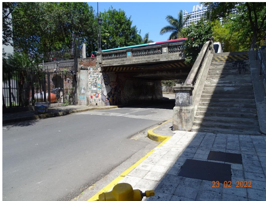
Figura 4.3. Vista lateral del costado sur del puente
