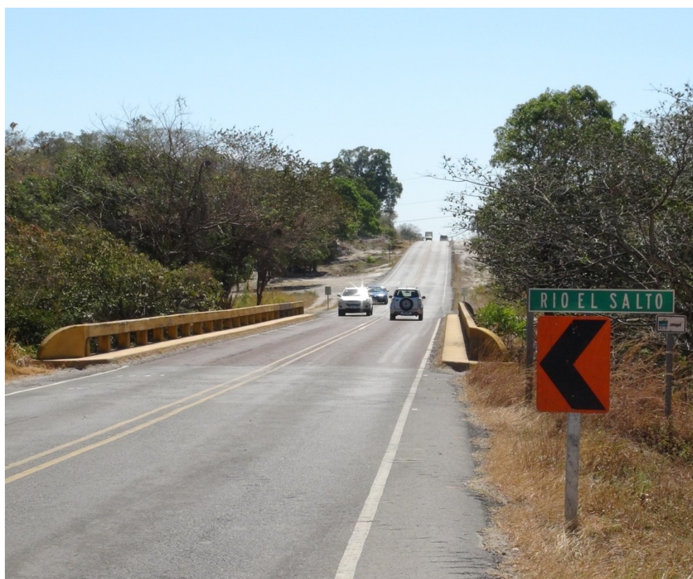
Figura 2: Vista a lo largo de la línea de centro del puente Río El Salto.
