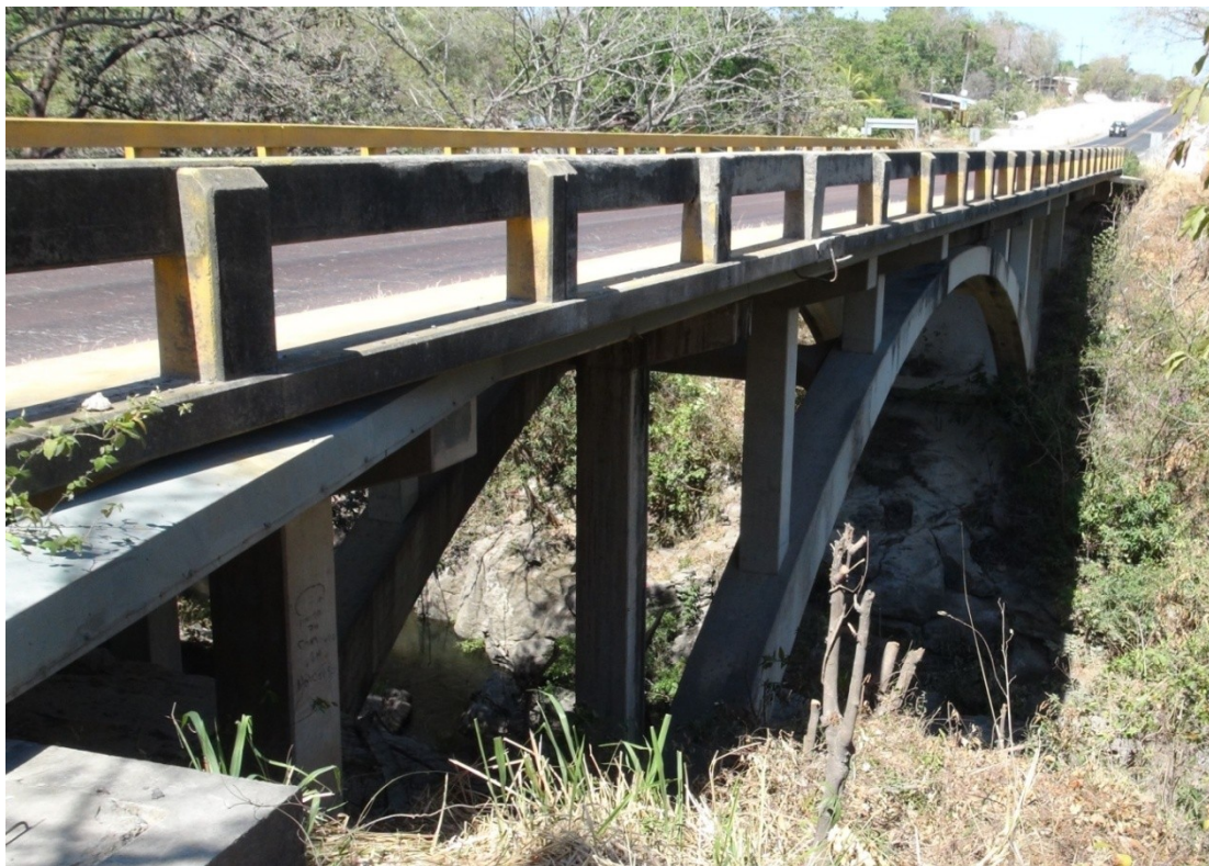
Figura 3: Vista lateral del puente Río El Salto.
