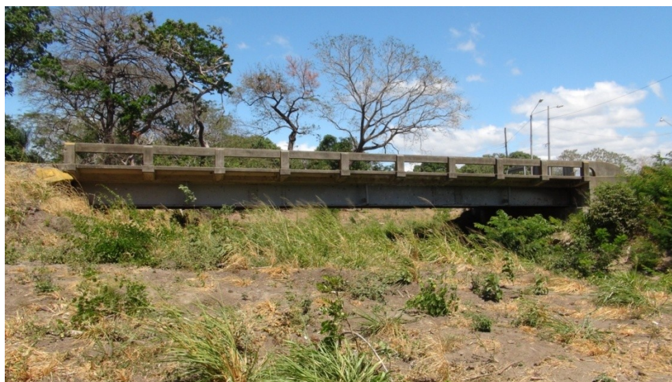
Figura 3: Vista lateral del puente sobre el Río Bagaces.
