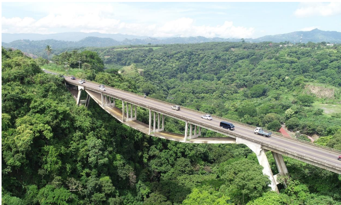
Figura 4.3. Vista lateral del puente (aguas arriba).
