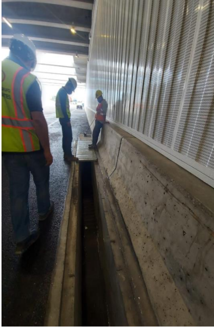
Figura 26. Canal colector CAZ drenajes pantalla de pilotes muro sector norte en el sentido San Pedro-Calle Blancos. Fecha: 23 de febrero de 2021
