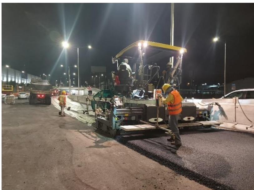
Figura 31. Proceso de pavimentación segunda capa, carril interno sentido San Pedro Paso Ancho. Fecha 01 de marzo de 2021
