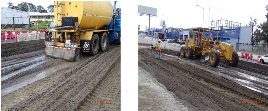
Figura 30. Dosificación de agua en proceso de estabilización de agregados, acumulación de agua producto de una dosificación no uniforme. Fecha 13 de enero de 2021.
