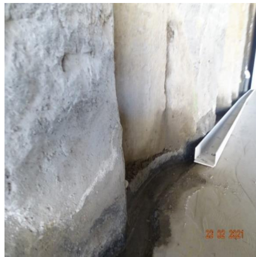
Figura 27. Agua acumulada en canal interno colector de drenajes horizontales pantalla de pilotes. Fecha: 17 y 23 de febrero de 2021
