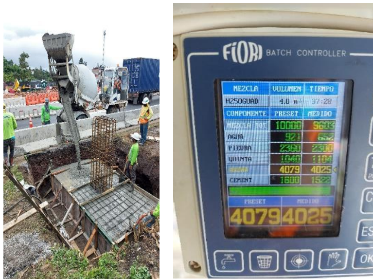
Figura 11. Colocación de concreto restante placa de fundación puente peatonal, resistencia de 250 kg/cm 2 . Fecha: 15 de octubre de 2020. Fuente: LanammeUCR.
