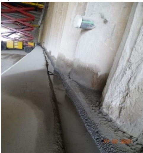
Figura 27. Agua acumulada en canal interno colector de drenajes horizontales pantalla de pilotes. Fecha: 17 y 23 de febrero de 2021
