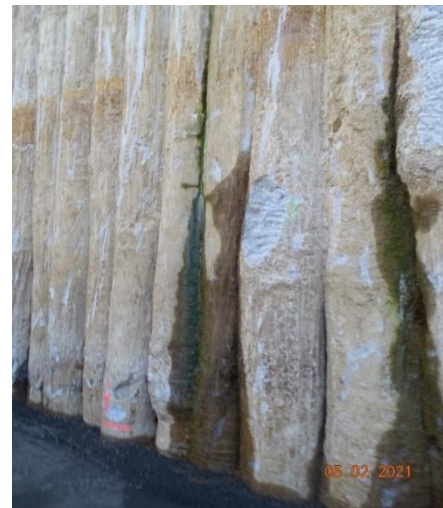
Figura 23. Filtraciones de agua pantalla de pilotes, sector sur muro en el sentido Calle Blancos - San Pedro. Fecha: 05 de febrero de 2021
