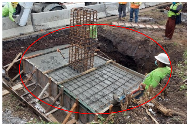
Figura 10. Nivel de concreto alcanzado ante la descarga del último de camión de concreto programado. Fecha: 15 de octubre de 2020. Fuente: LanammeUCR
