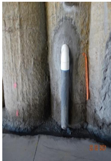
Figura 25. Drenajes transversales a pantalla de pilotes y canal interno de concreto construido como colector de drenajes. Fecha: 23 de febrero de 2021
