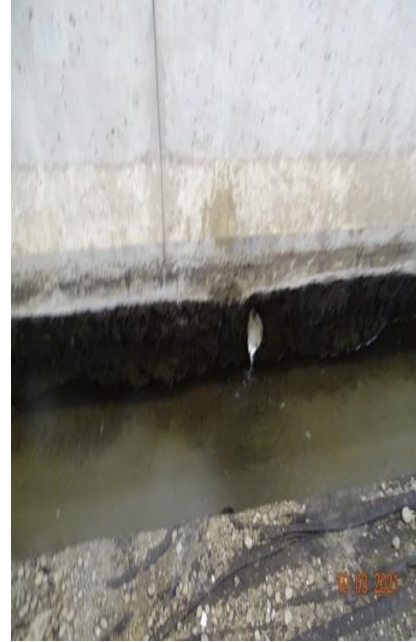
Figura 26. Canal colector CAZ drenajes pantalla de pilotes muro sector norte en el sentido San Pedro-Calle Blancos. Fecha: 23 de febrero de 2021
