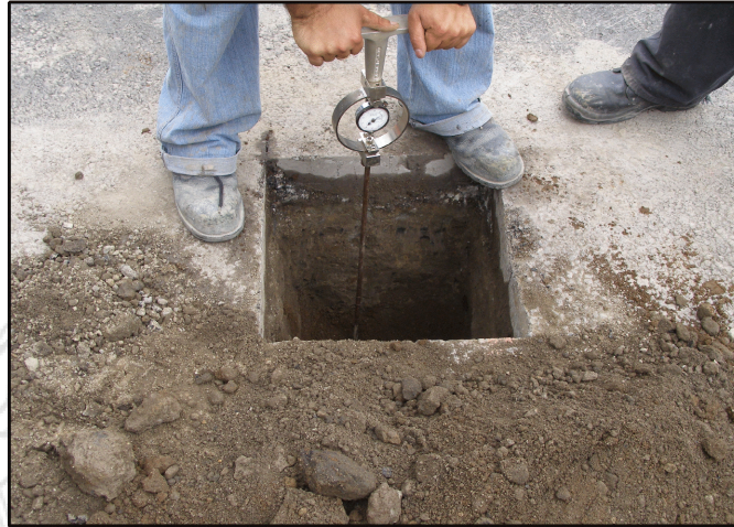
Figura 34. Prueba de CBR en sitio.
