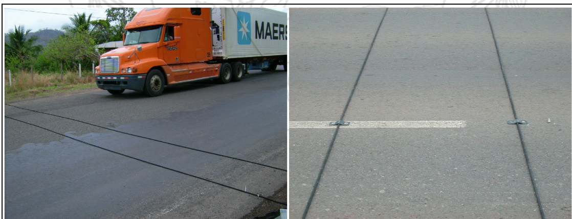
Figura 4. Cables y contadores automáticos en sitio.
