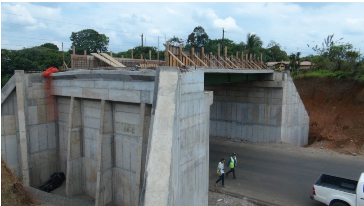
Figura 23: Paso a desnivel 14+747: Vista general mostrando el avance en la construcción.
