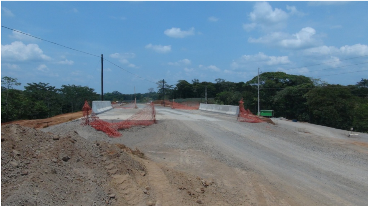
Figura 16: Paso a desnivel 6+200: Vista a lo largo de la línea de centro
