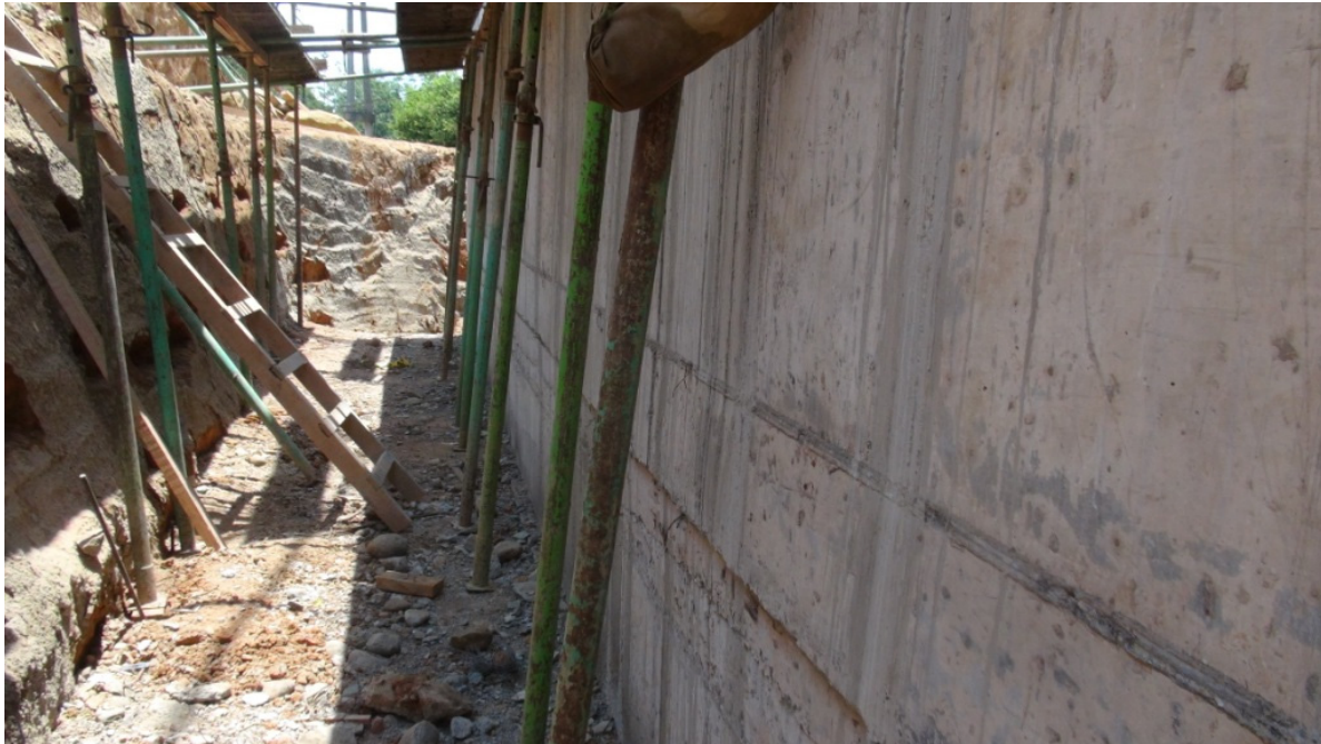
Figura 6: Paso a desnivel 1+551:Acabado de la superficie de concreto del muro del bastión
