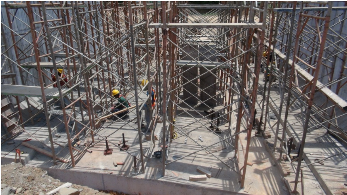
Figura 5: Paso a desnivel 1+551: Ya está colada la losa inferior del puente y se tienen colocados los puntales necesarios para colar la losa superior.
