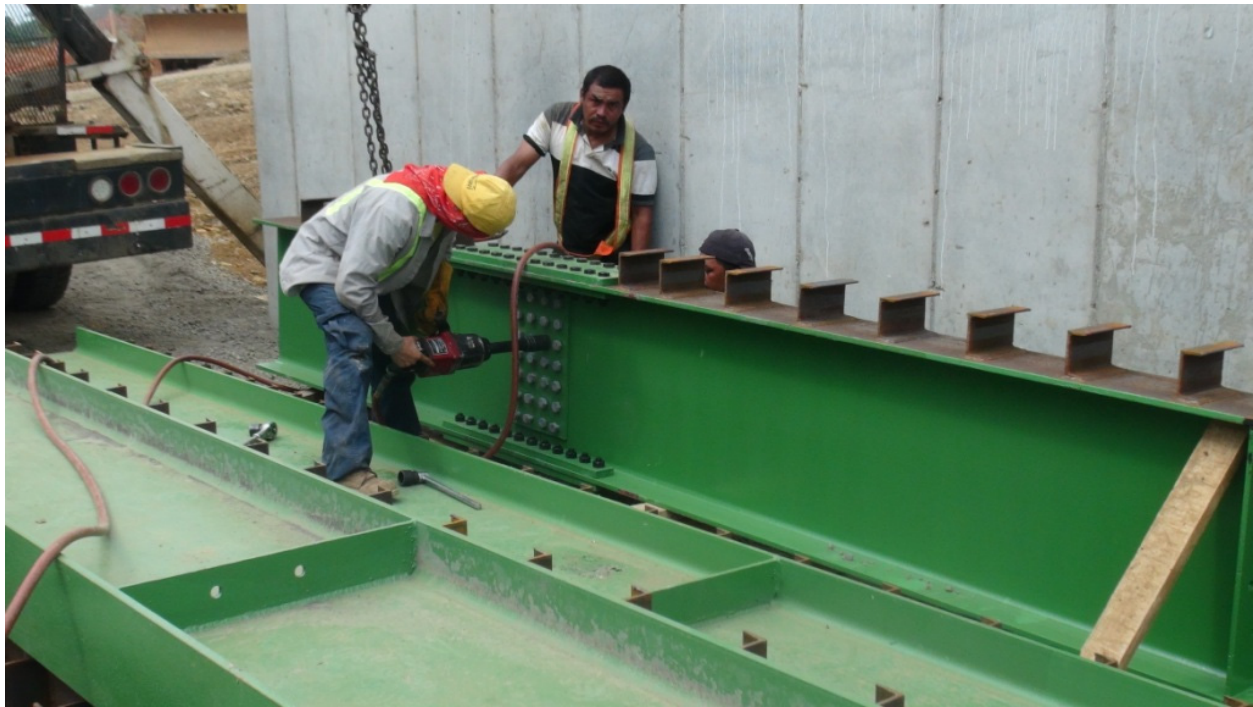
Figura 28: Paso a desnivel 19+874: Se muestran los trabajos realizados en las conexiones de las vigas
