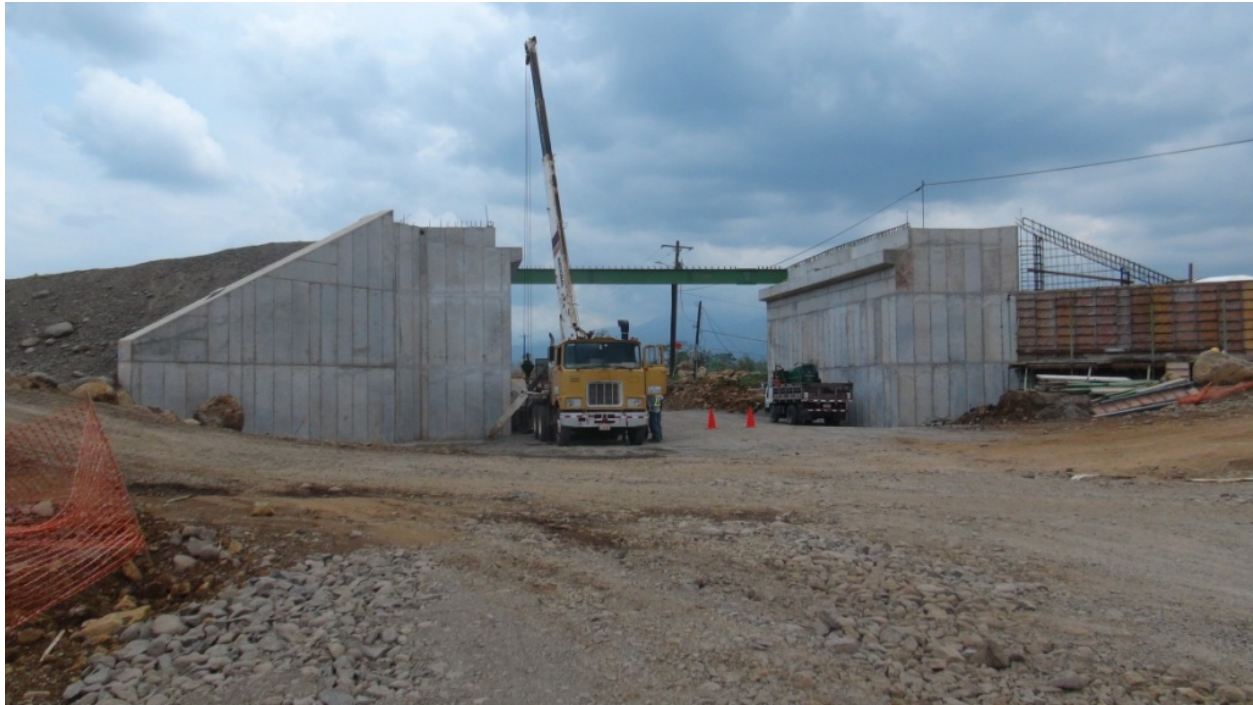
Figura 26: Paso a desnivel 19+874: Vista lateral del puente
