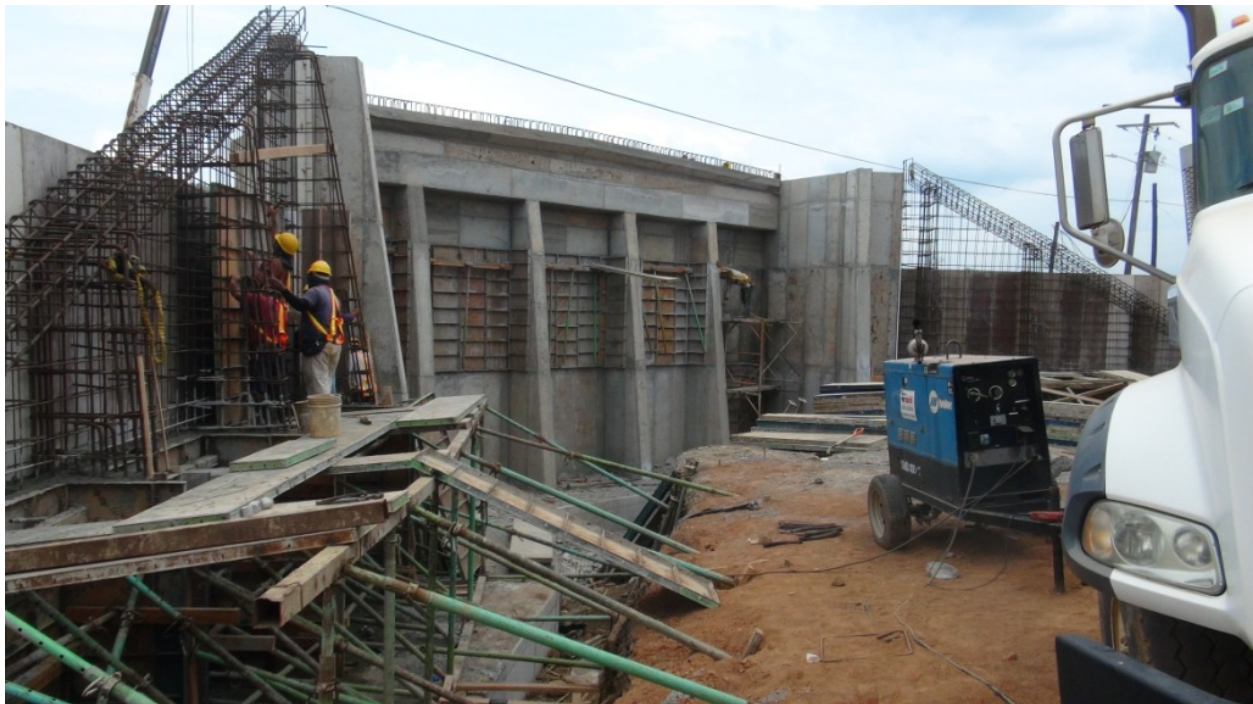
Figura 27: Paso a desnivel 19+874: Vista de bastión del puente
