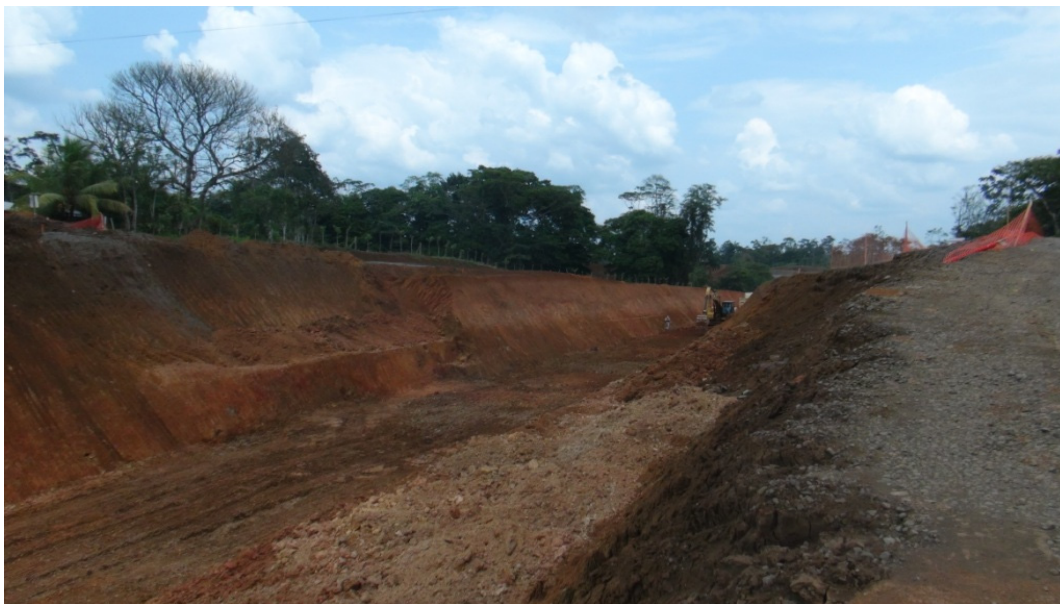
Figura 19: Paso a desnivel 11+854: Ya inició el movimiento de tierras donde se ubicará el puente.
