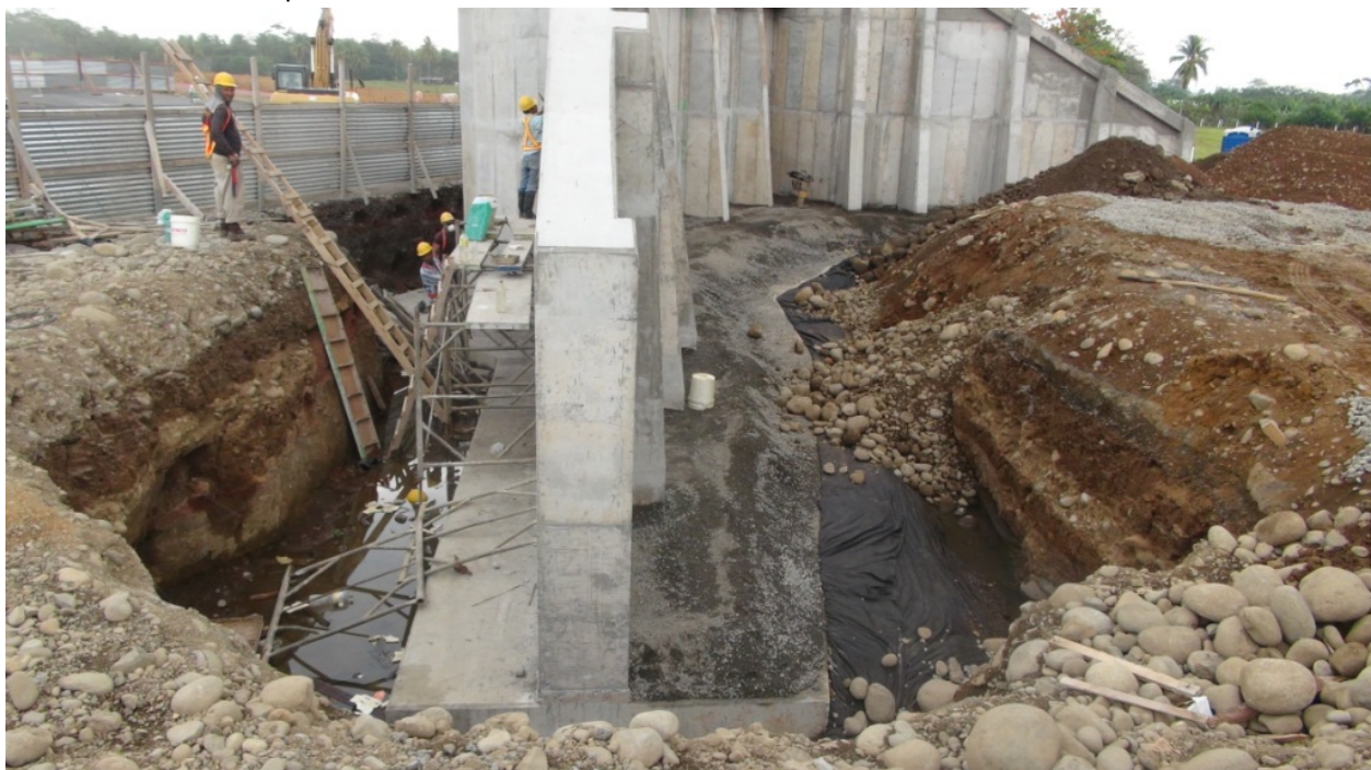
Figura 31: Paso a desnivel 27+013: Se muestra los trabajos del sistema de drenaje del bastión y se realizan mejoras al acabado de la superficie expuesta.
