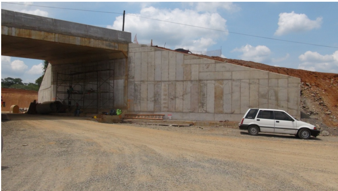
Figura 17: Paso a desnivel 6+200: Vista lateral mostrando la construcción de todos los elementos de la subestructura y superestructura.
