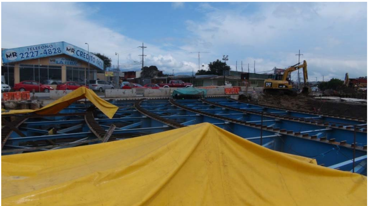
Figura 4. Vigas curvas de acero y armaduras transversales conectado dichas vigas. Puente-Oeste
