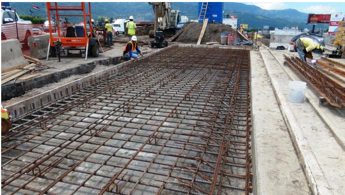
Figura 10. Finalizando el detallado de la losa de aproximación Sur del puente-Este previo a su colado.
