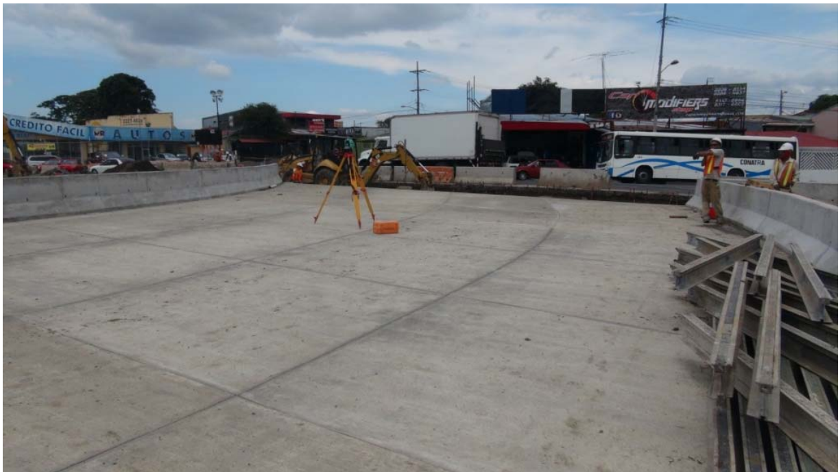
Figura 1. La losa del puente-Este ya fue colada. Se muestran las juntas de contracción
