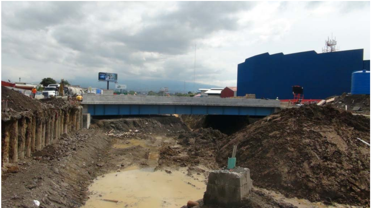
Figura 3. Excavación del relleno bajo la superestructura del puente-Este.
