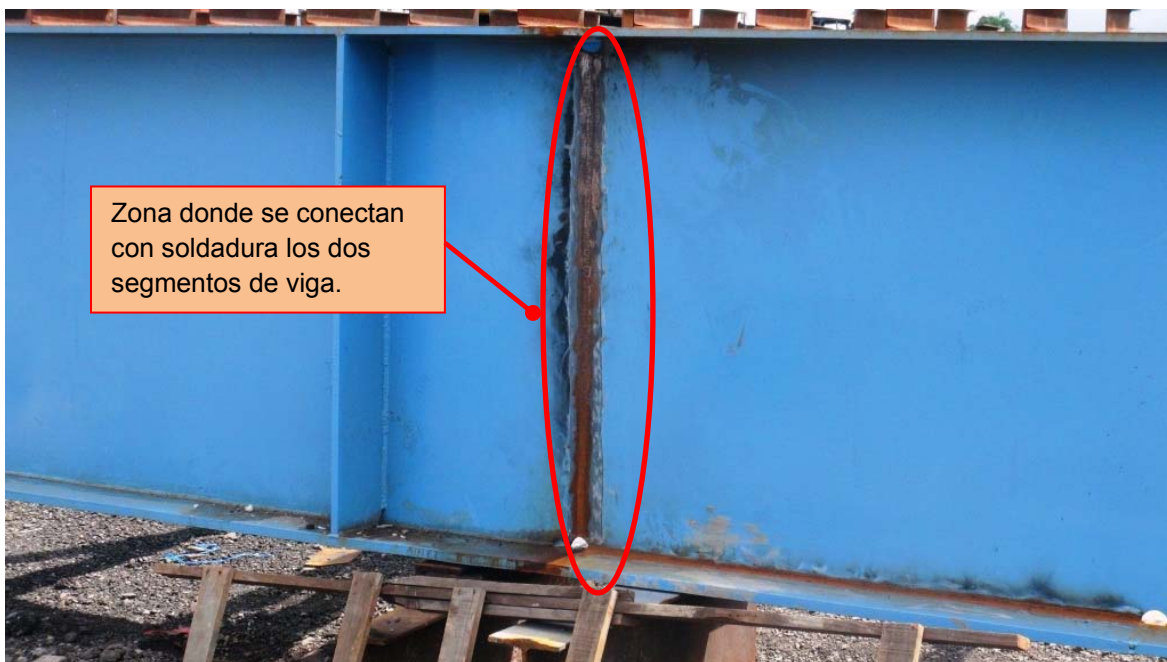
Figura 6. Detalle típico de soldadura entre dos segmentos de viga curva. Puente-Oeste
