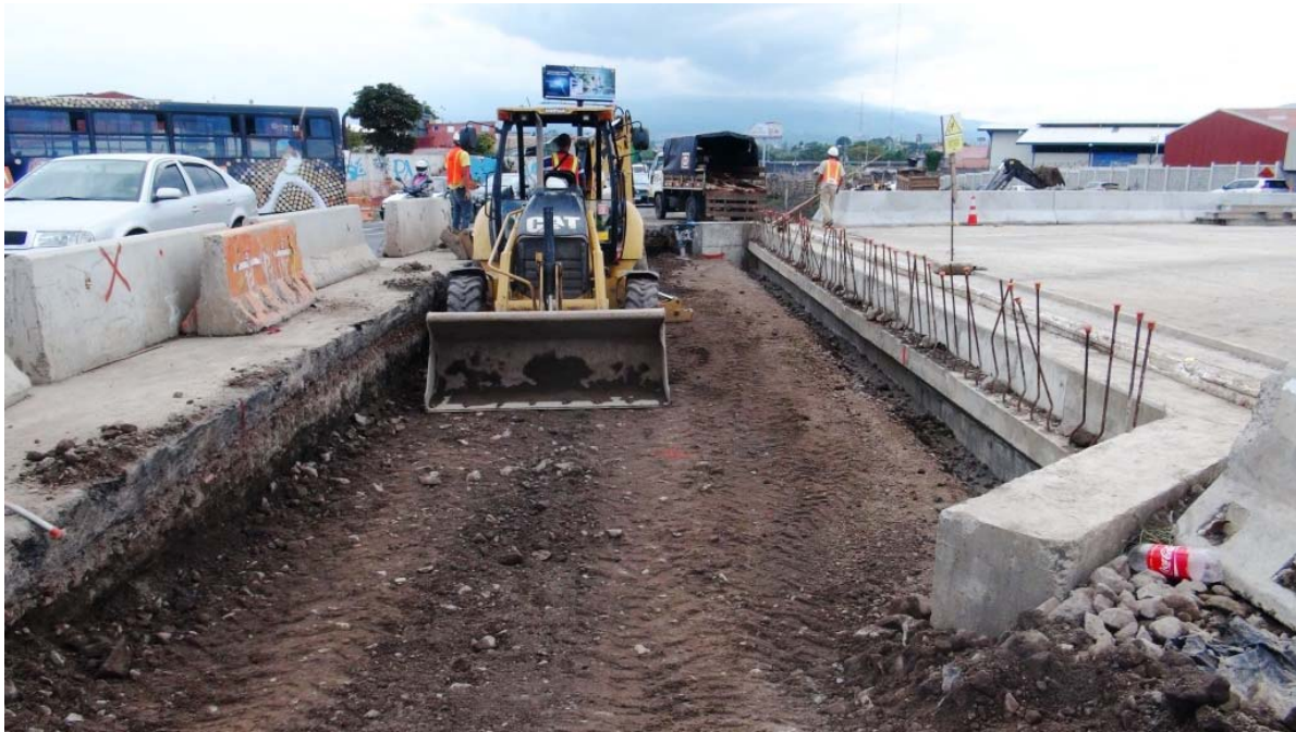
Figura 9. Preparación de superficie para iniciar el armado y el colado de la losa de aproximación Norte del puente-Este.
