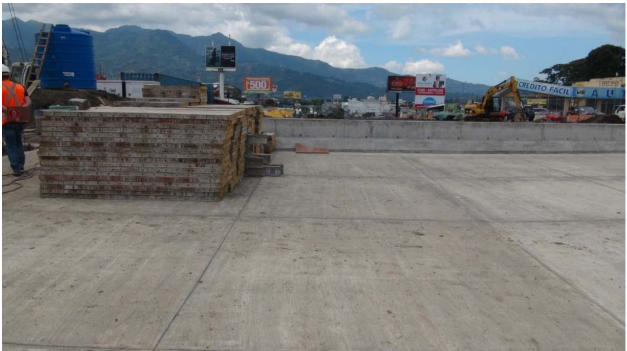
Figura 2. Se observan juntas de contracción en la losa y en la barrera vehicular del puente-Este.
