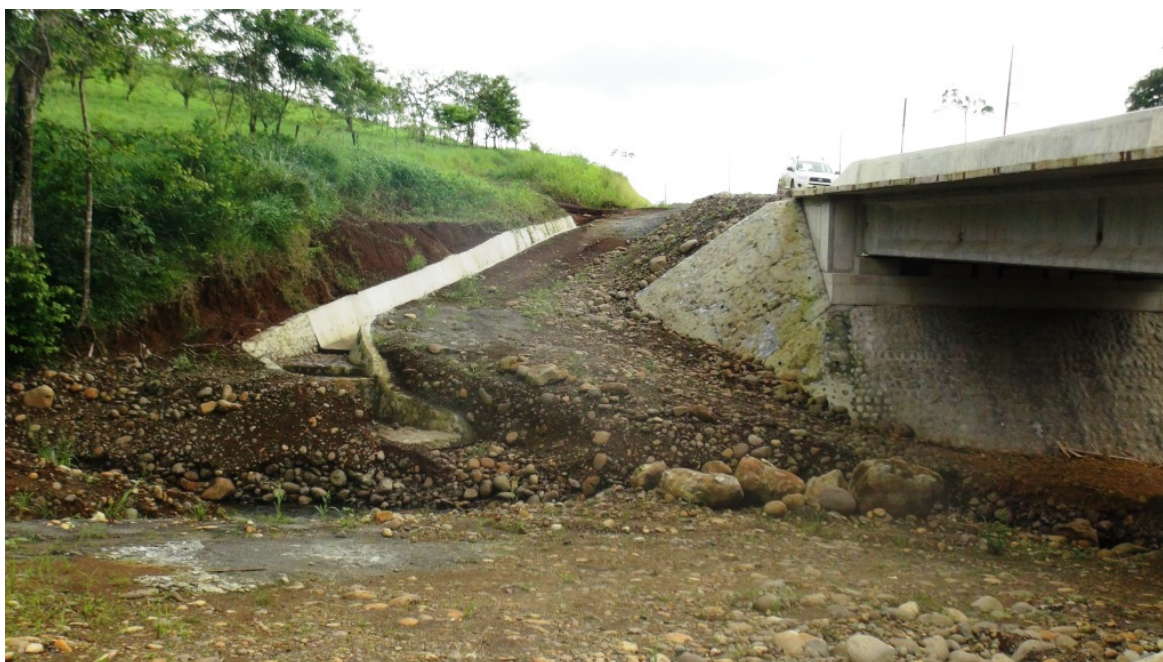
Figura 40: Vista lateral (sentido Este-Oeste) donde se muestra la escollera frente al bastión-Oeste y el sistema de drenaje del acceso. Puente sobre Quebrada Campamento.
