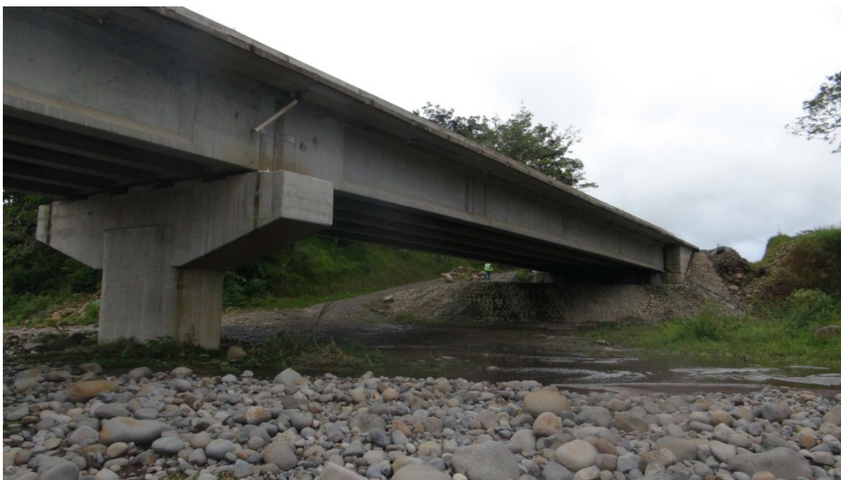
Figura 25. Ya está construida la escollera del bastión-Este. Puente sobre el Río Toro.
