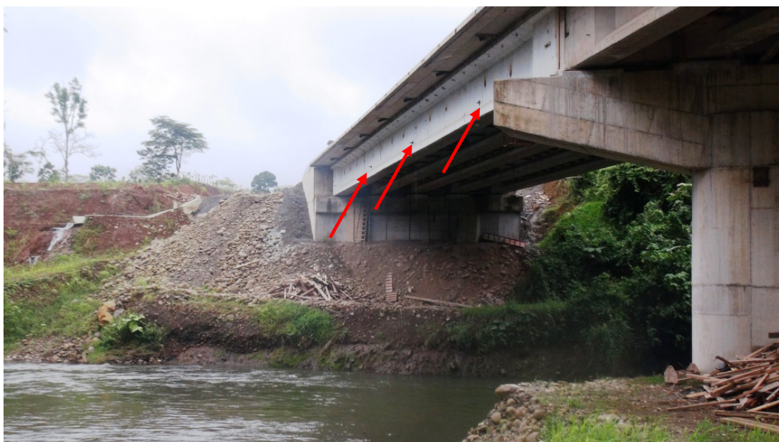
Figura 10. Vista lateral (costado Norte) mostrando que todavía no se ha construido la escollera de bastión Este y no se ha realizado el anclaje del acero de refuerzo de las vigas diafragma intermedias. Puente sobre el Río Cuarto.
