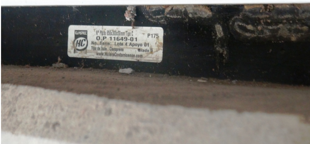
Figura 43: Información sobre la almohadilla elastomérica utilizada en el puente sobre la Quebrada Campamento.
