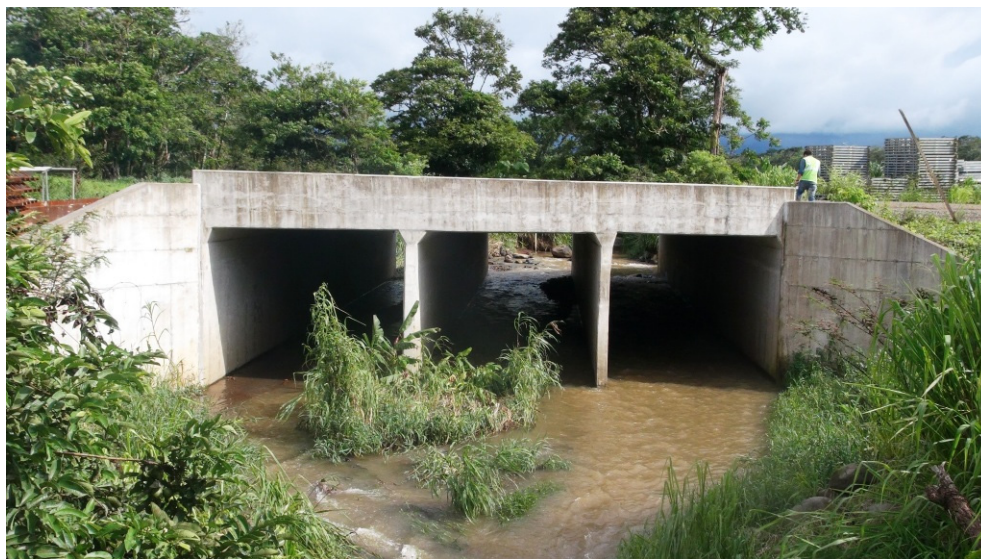
Figura 29. Vista lateral. Alcantarilla sobre la Quebrada San Pedro.
