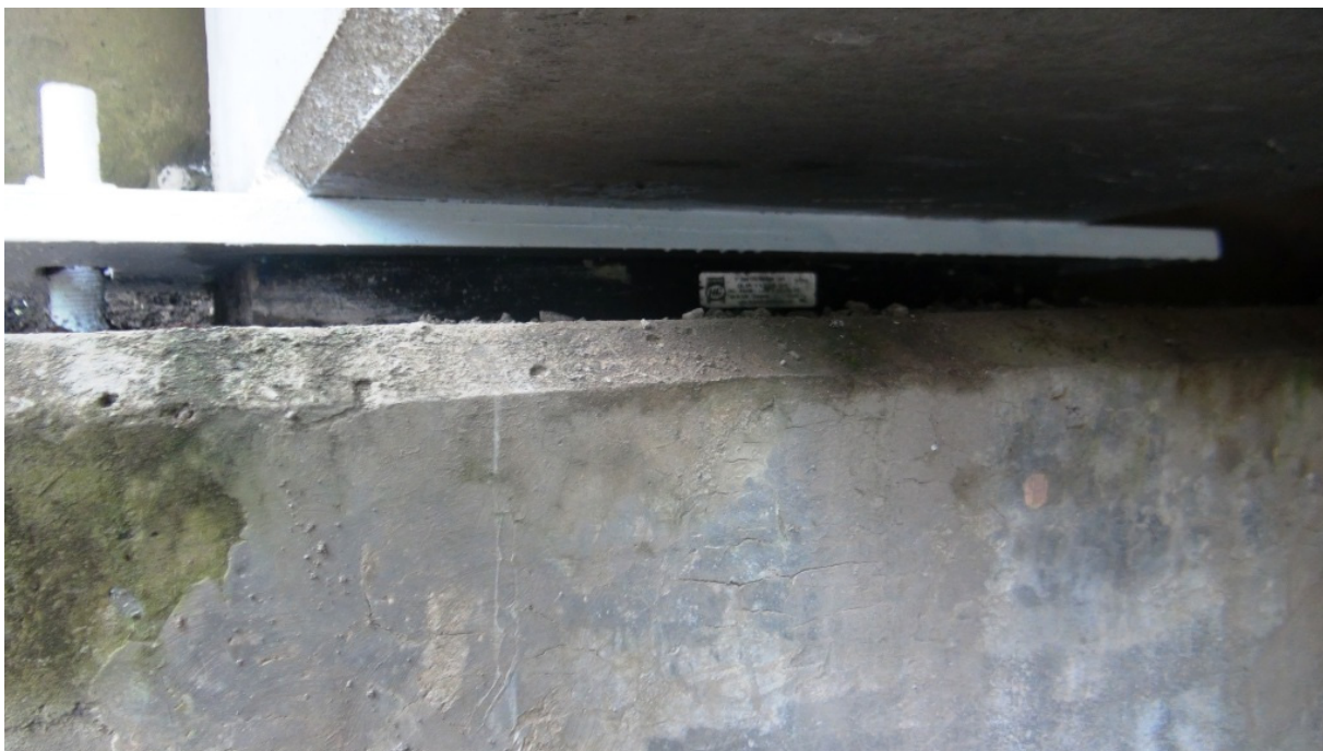
Figura 27. Apoyos de neopreno suministrados por la Hulera Costarricense. Puente sobre el Río Toro.
