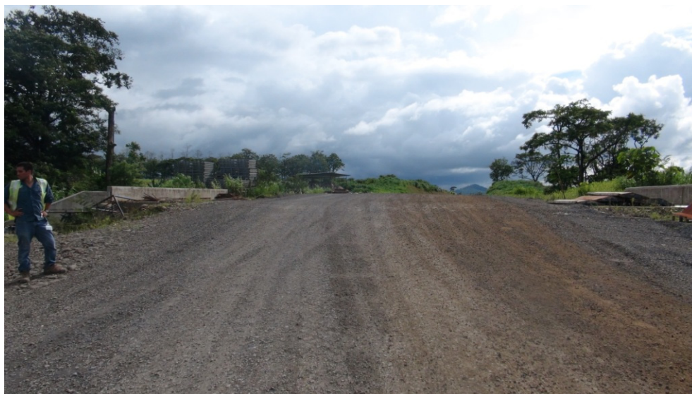
Figura 28. Vista a lo largo de la línea de centro. Alcantarilla sobre la Quebrada San Pedro.
