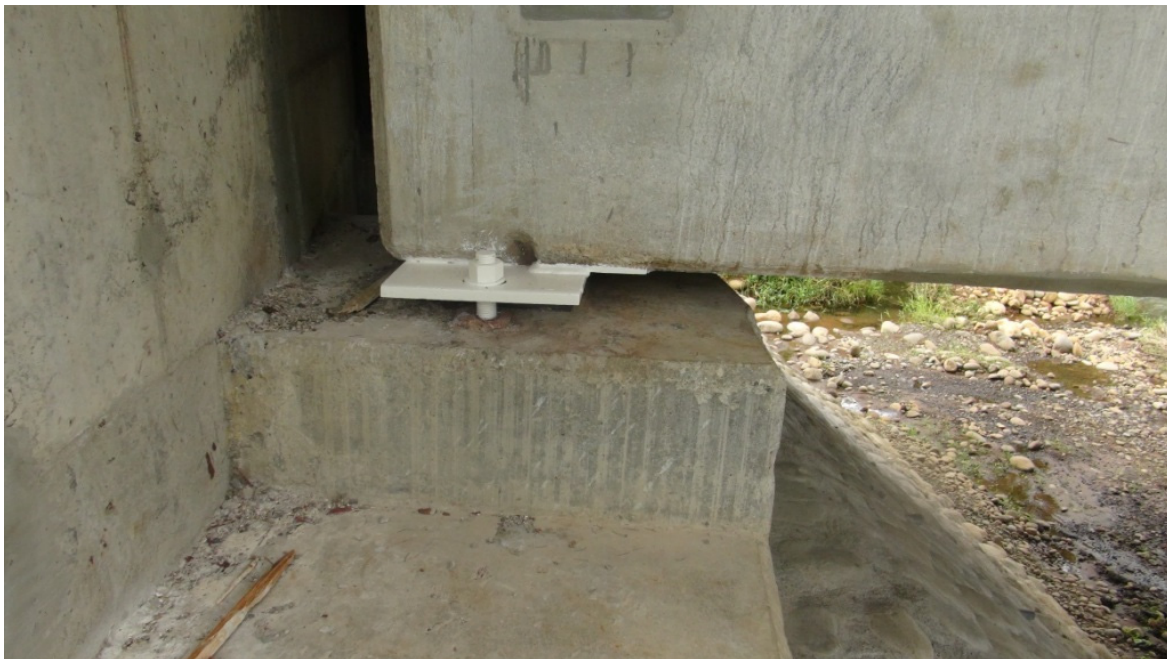
Figura 37: Las placas de los apoyos fueron protegidas con pintura. Puente sobre la Quebrada Pericos.
