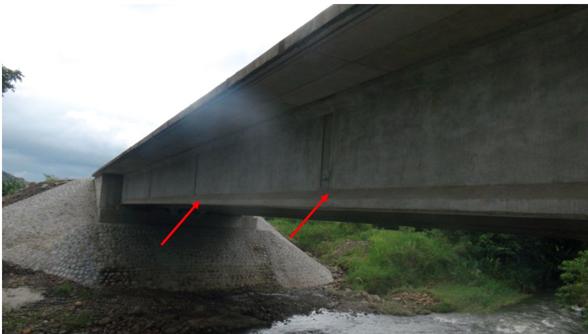
Figura 33: Vista lateral donde se observan las placas de conexión de las vigas diafragmas. Puente sobre Quebrada Pericos.
