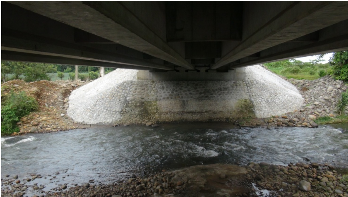
Figura 36: Se completó la escollera del bastión-Oeste. Puente sobre la Quebrada Pericos.
