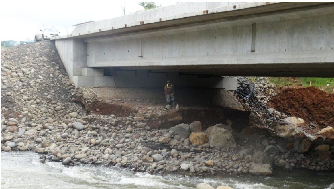
Figura 20. Todavía no ha iniciado la construcción de la escollera del bastión - Oeste. Puente sobre del Rio Caño Negro.
