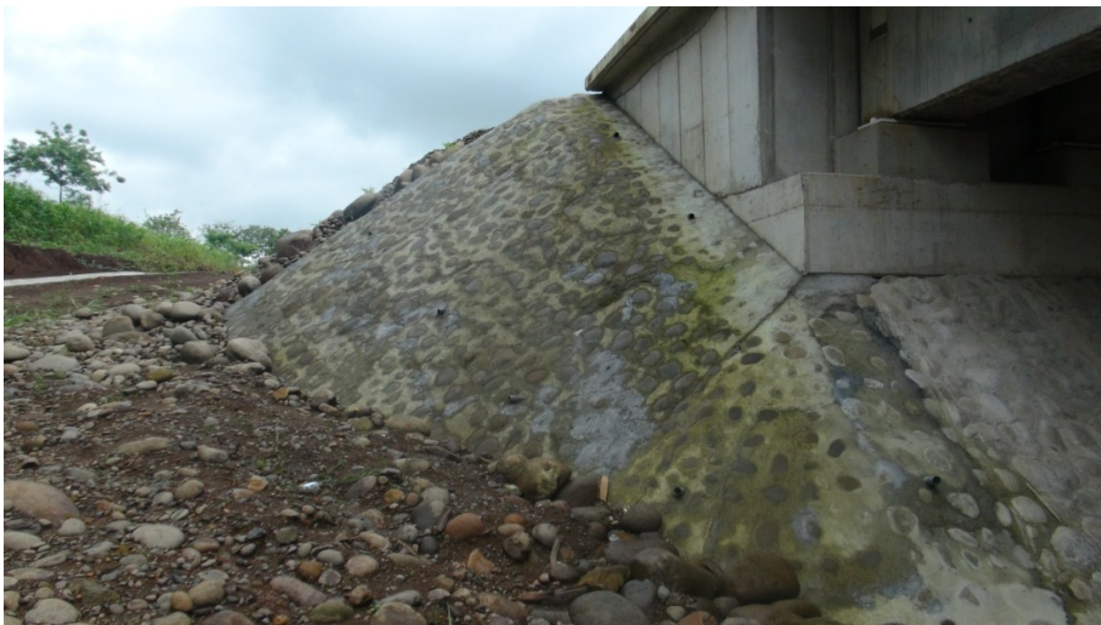
Figura 44: Vista lateral (sentido Este-Oeste) mostrando la escollera del bastión-Este donde se observan tubos de drenaje. Puente sobre Quebrada Campamento.
