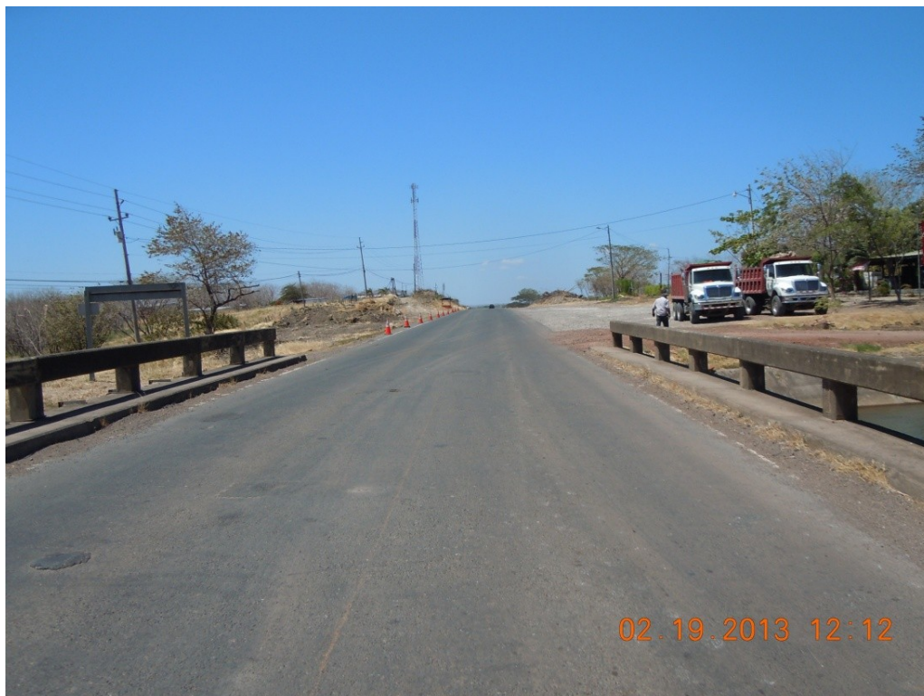
Figura 2: Vista a lo largo de la línea de centro del puente
