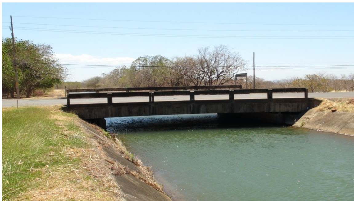
Figura 3: Vista lateral del puente
