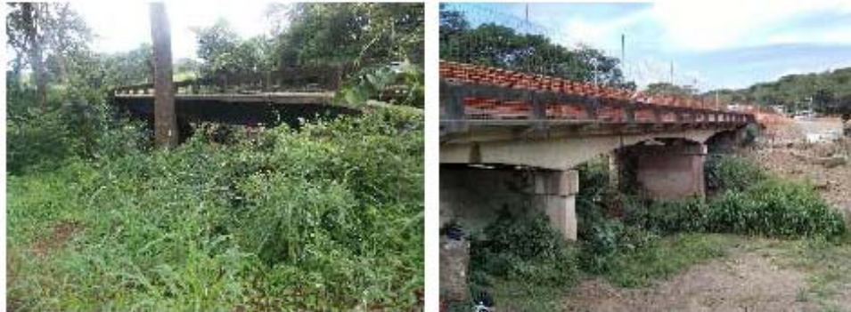
Figura 5. a) Puente sobre el Río Desjarretado b) Puente sobre el Río Jabillos
