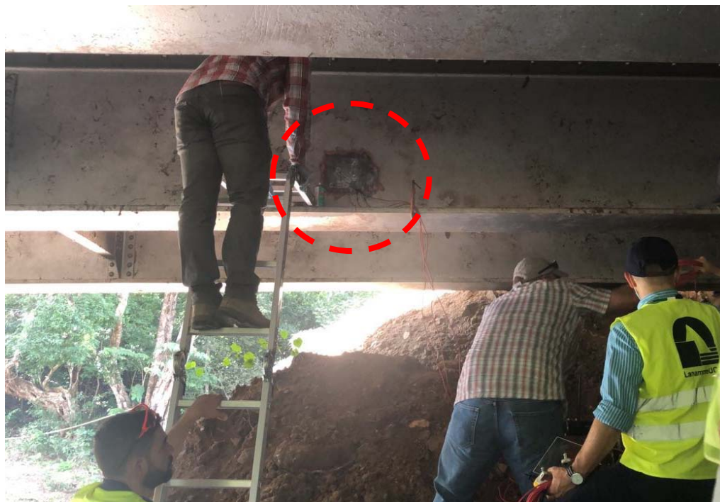
Figura 1. Colocación de sensores en vigas del puente sobre el río Desjarretado.
