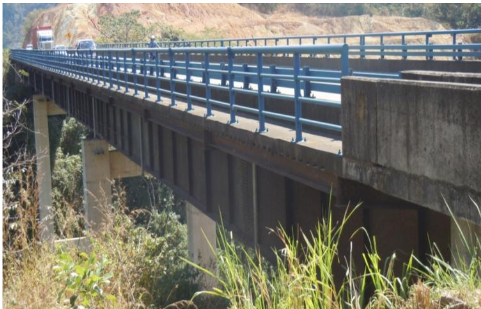
Figura 4: Vista lateral norte del puente sobre la Quebrada Salitral.
