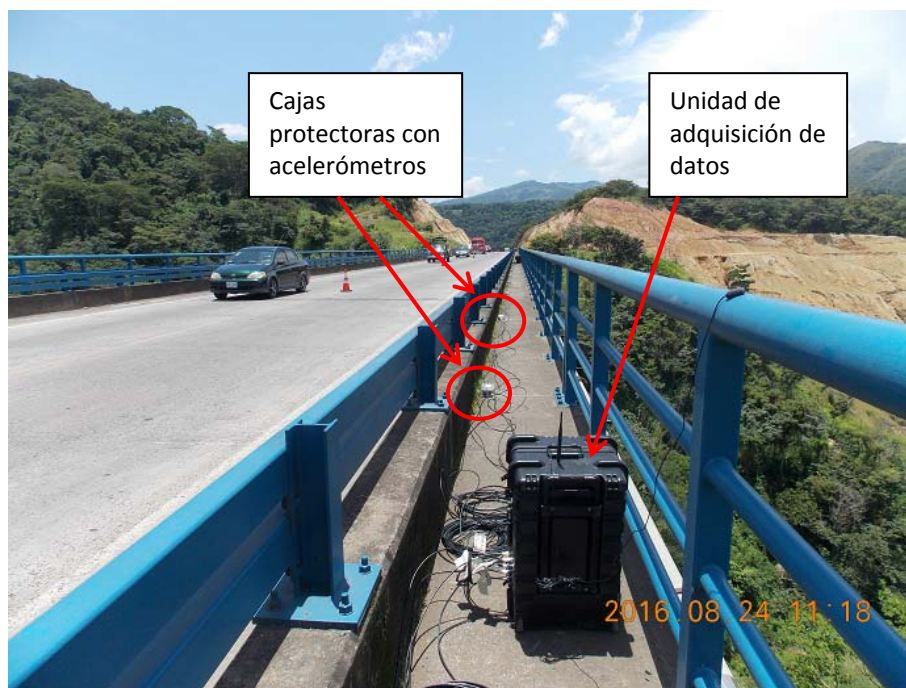
Figura 10. Colocación de sensores sobre las aceras del puente. Nótese que el monitoreo no interrumpe el tránsito de vehículos.
