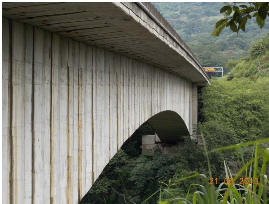
Figura 4: Vista lateral norte del puente sobre la El río Grande.
