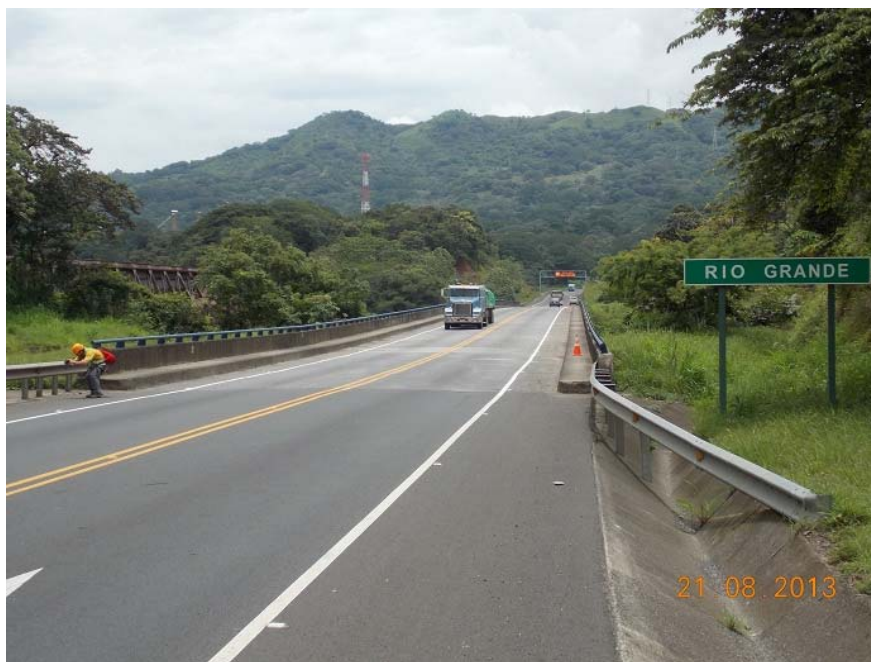
Figura 3: Vista a lo largo de la línea de centro del puente sobre el río Grande.
