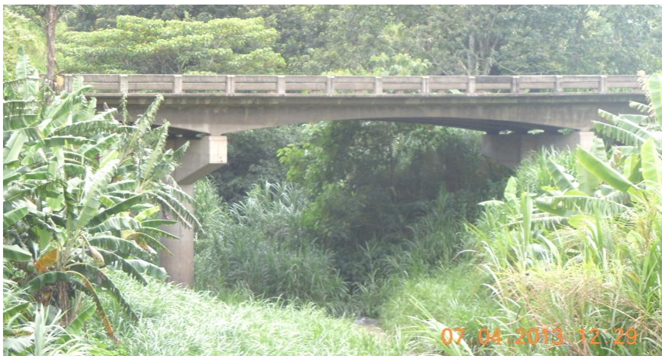
Figura C: Vista lateral del puente.
