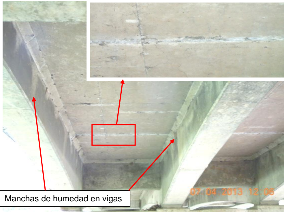
Figura 9: Eflorescencia en juntas de construcción en la superficie inferior de la losa y manchas de humedad en el alma de las vigas principales producto de filtración de agua a través de las juntas de construcción de la losa
