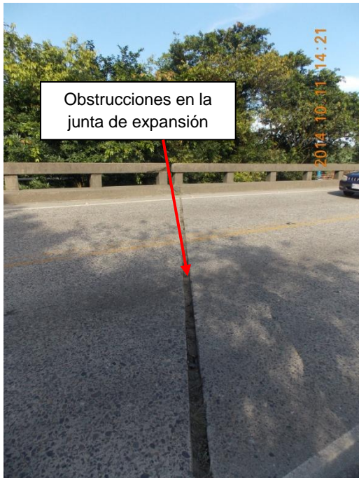
(a) Junta entre superestructuras 1 y 2
