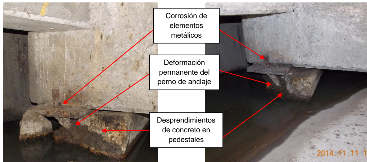
(a) Apoyo sobre el bastión 1
