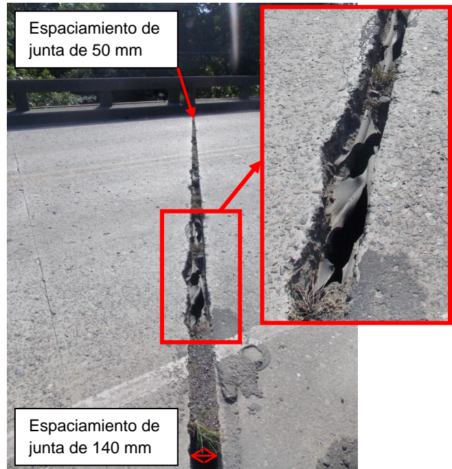
(a) Junta entre superestructuras 2 y 3
