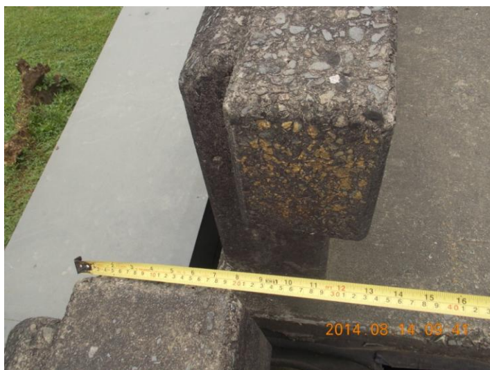
(A) Medición entre superestructuras 2 y 3
