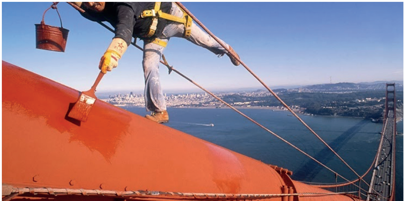
Figura 1. Trabajos de conservación del sistema de protección de pintura, puente Golden Gate, San Francisco, EUA. Tomado de: https://goldengatebridge14.wordpress.com/2014/12/16/maintenance-of-the-golden-gate-bridge/
