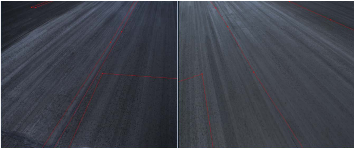
Figura A. 9 Grieta Longitudinal. Carril 4
