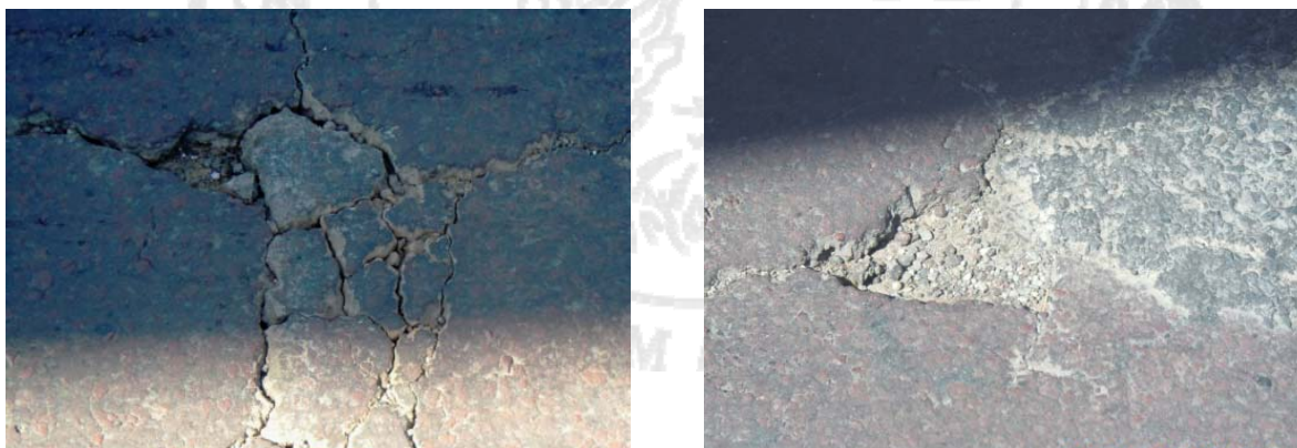
Figura 10: Baches en la superficie de rodamiento.
