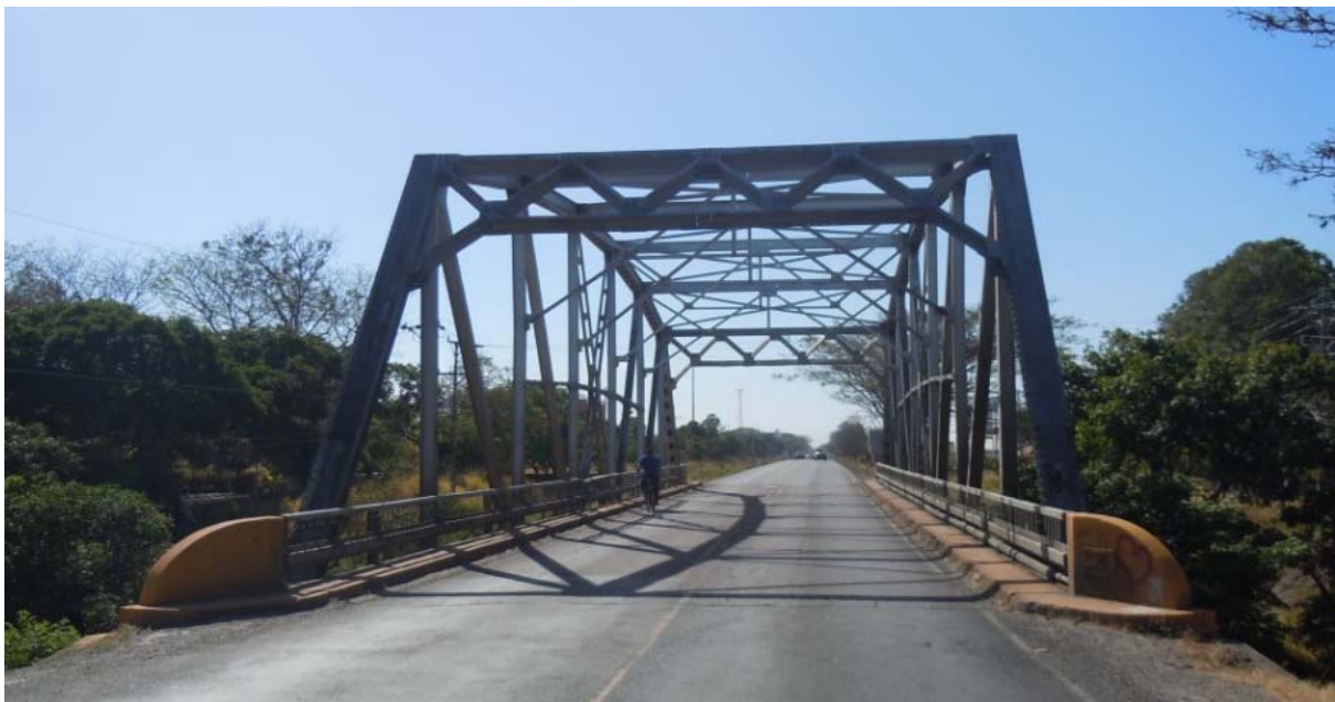
Figura 2: Vista a lo largo de la línea de centro.
