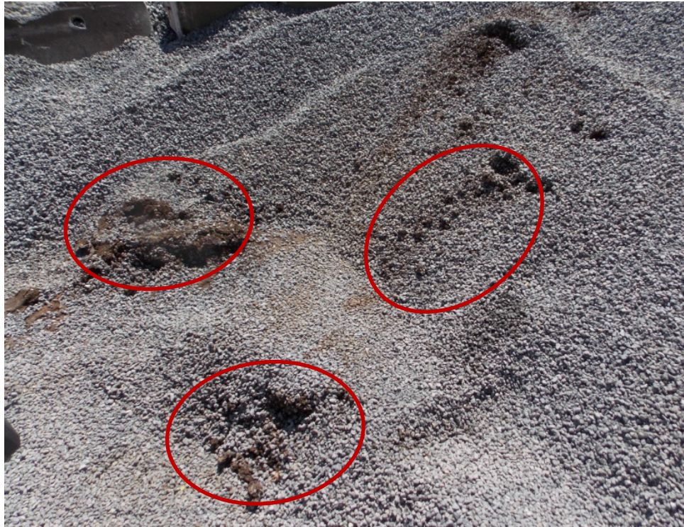
Fotografía 3. Presencia de terrones en los apilamientos de los agregados. Fecha: 24/02/17. Fuente: Unidad de Auditoría Técnica.
