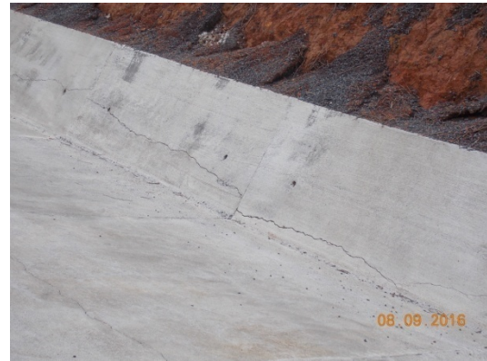
Figura 13 y Figura 14. Apilamiento de material y el agrietamiento causado a la cuneta. Estacionamiento 13+100. Fecha de las fotografías 2/10/2015 y 08/09/2016. Fuente: LanammeUCR.
