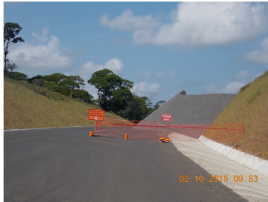
Figura 13 y Figura 14. Apilamiento de material y el agrietamiento causado a la cuneta. Estacionamiento 13+100. Fecha de las fotografías 2/10/2015 y 08/09/2016. Fuente: LanammeUCR.
