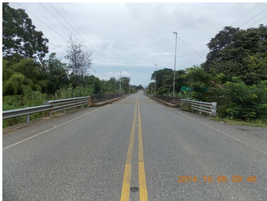
Figura B: Vista a lo largo de la línea de centro
