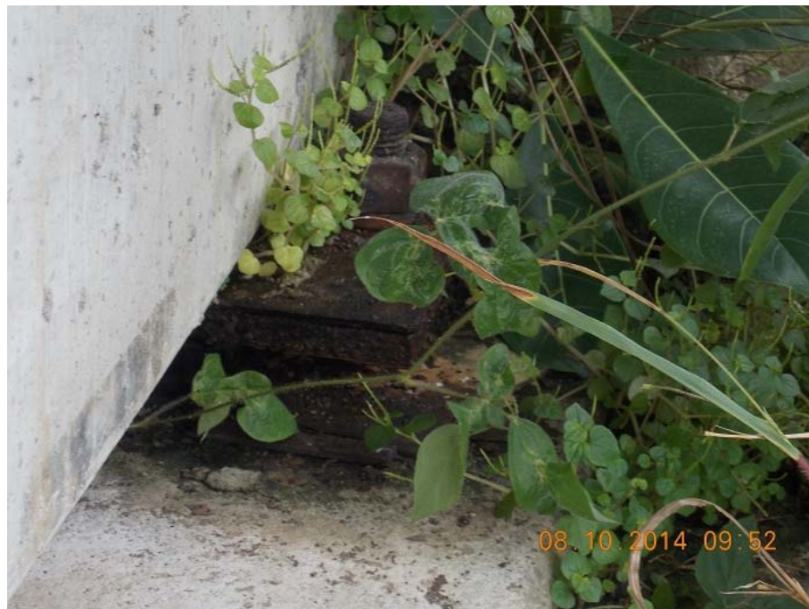
Figura 10: Apoyo en contacto con vegetación y sedimentos.
