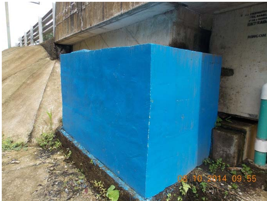
Figura 13: Tanque junto al bastión 1.
