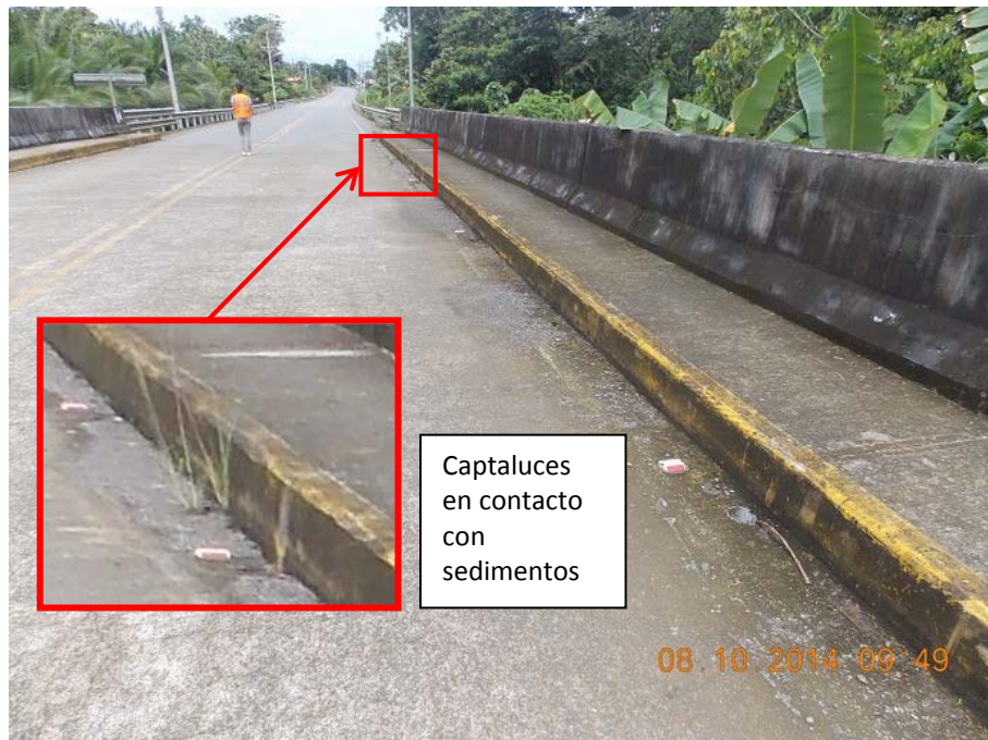
Figura 4: Captaluces en contacto con sedimentos
