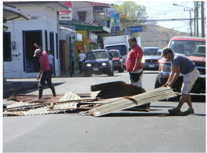
Figura 2. Desprendimiento de láminas de techo en Cañas el 7 de marzo de 2015 Fuente: La Nación, 2015
