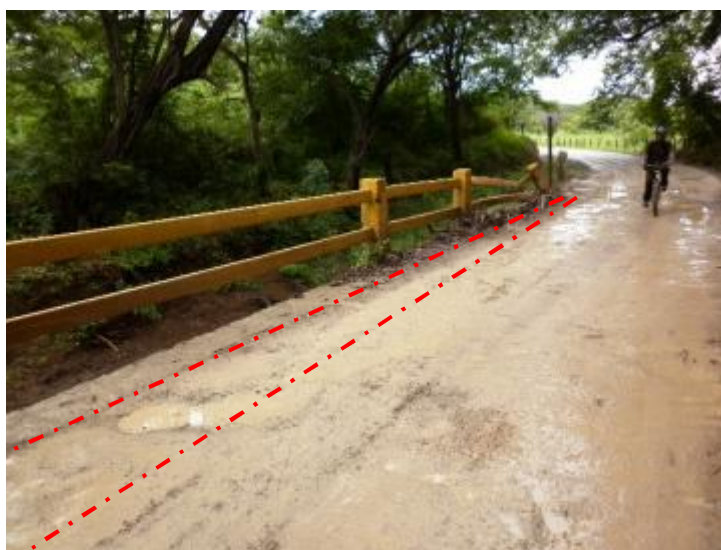
Figura 4. Ausencia y mal estado de las barandas del puente.
