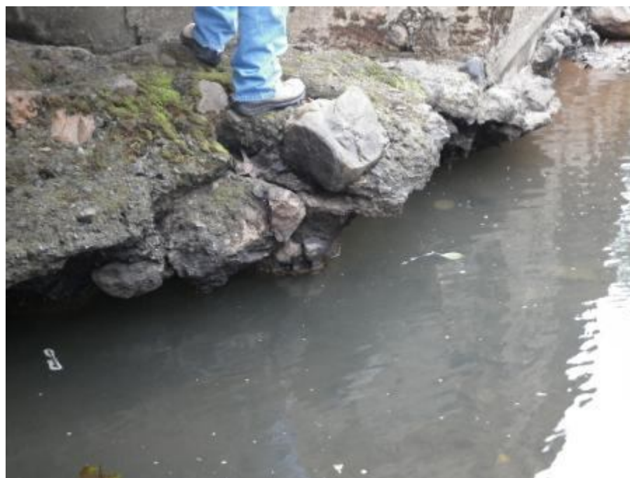
Figura 17. Juntas frías en aletones. Discontinuidad entre bastión y aletón.
