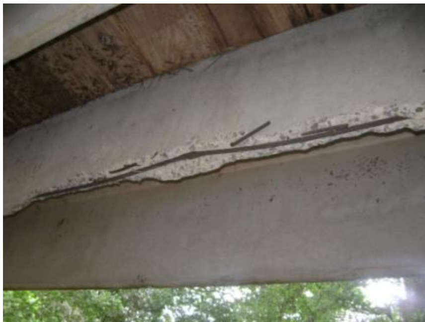
Figura 12. Formaleta dejada desde la colada de la losa impide realizar una inspección detallada.
